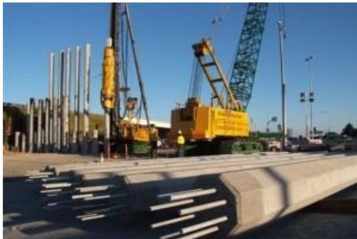
*Nota: Pilotes prefabricados de hormigón pretensado. Fuente: (Yepes Piqueras, 2020)*
