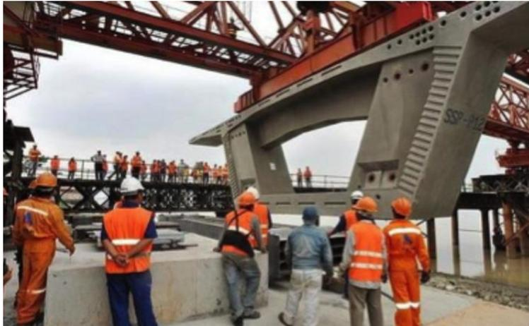
*Nota: Proceso de acoplamiento de las Dovelas presforzadas en la construcción del cuarto puente de la Unidad Nacional Fuente: (Fractales, 2020)*
