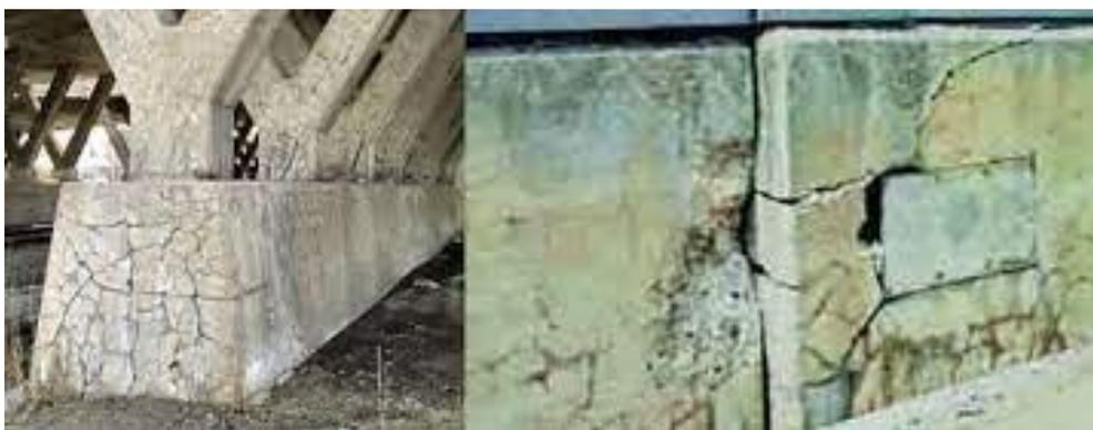
*Nota: Se observa el agrietamiento del hormigón producto de la reacción álcali – sílice del hormigón, que afecta en gran medida a la estructura. Fuente: (La Puzolana de Pumita Mitiga La Reacción Álcali-Sílice (ASR))*
