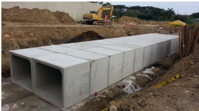
*Nota: Ductos prefabricados de hormigón pretensado. Fuente: (Fabrica de Tubos de Hormigón En Guayaquil, 2019)*
