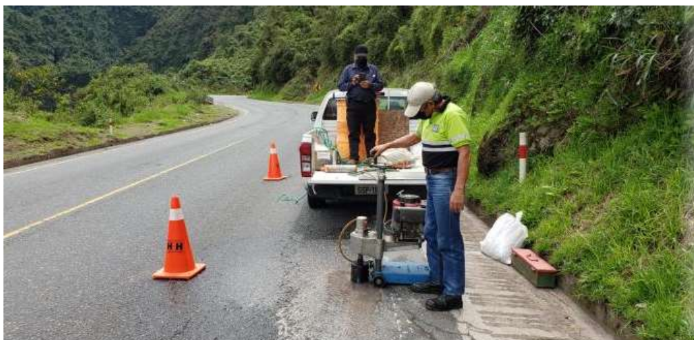
Figura 17. Extracción de núcleos en el Tramo 1.
