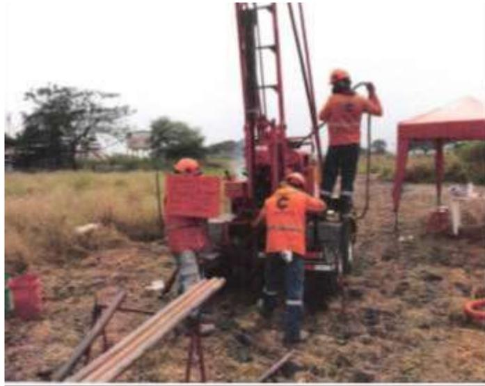
*Ilustración 18. Extracción de muestra por perforación.*
