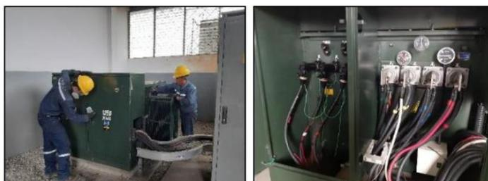
Limpieza externa e interna del transformador de 1250kVA, limpieza de cables.
