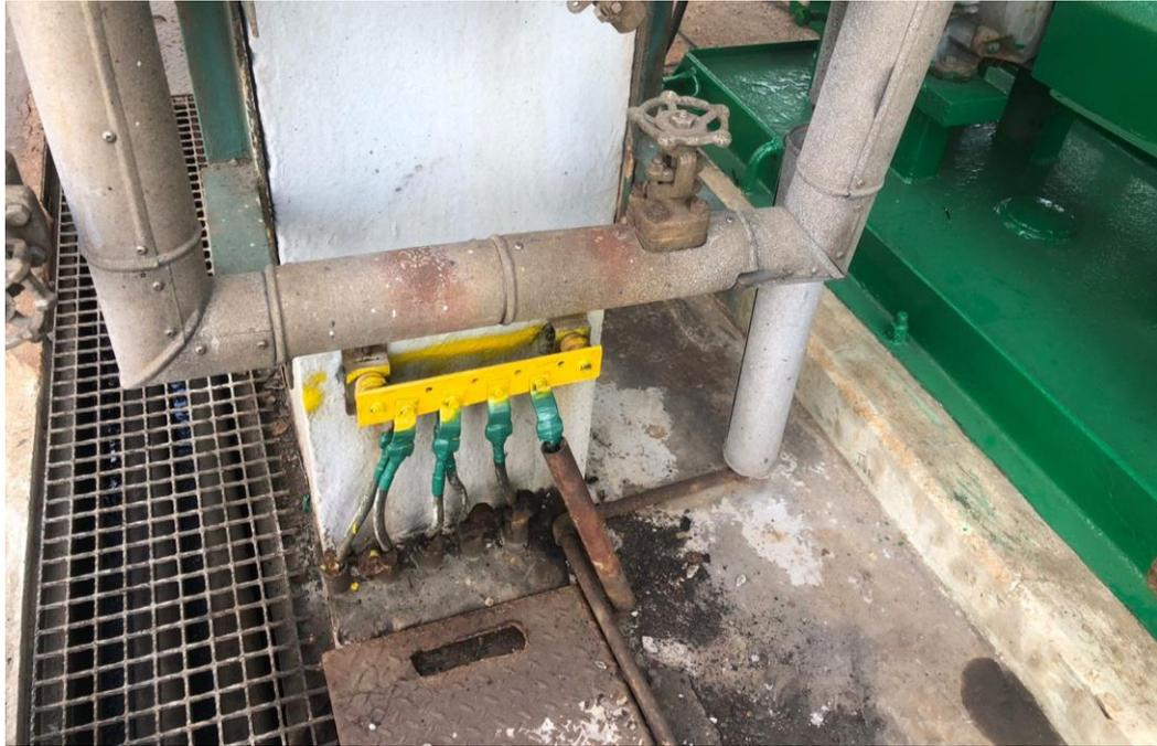
*Figura 1.6 Barra de conexión un Sistema Puesta a Tierra (SPT).*
