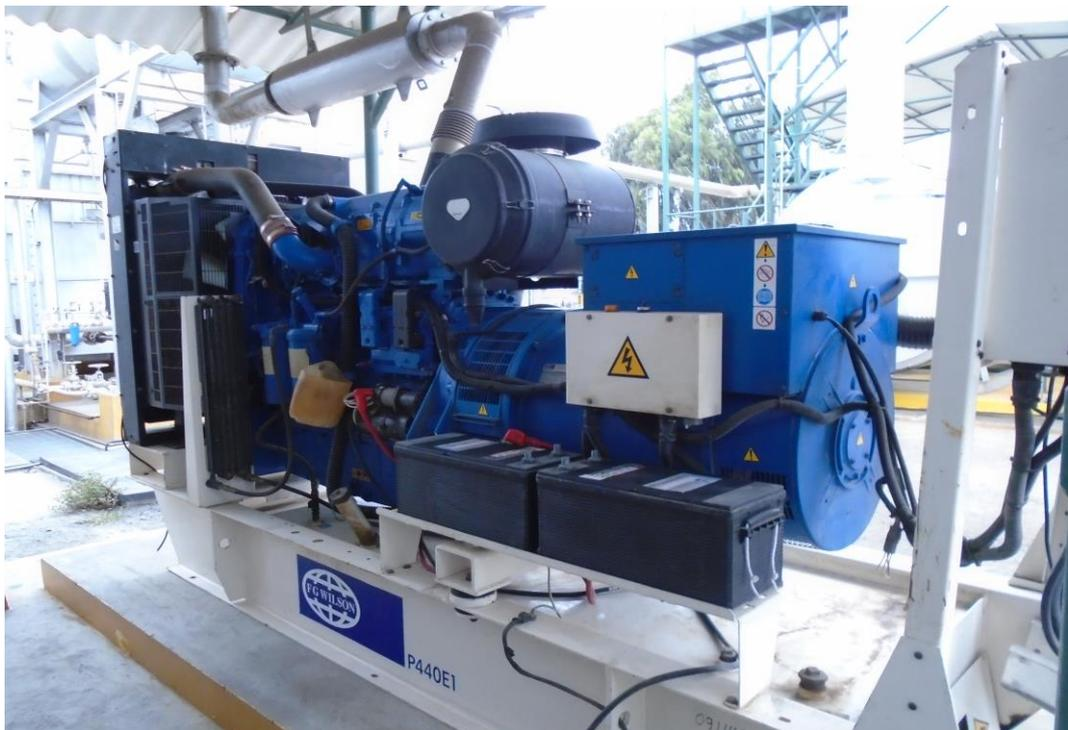
Figura 1.15 Grupo electrógeno formado por un motor de combustión interna y un alternador de CA.
