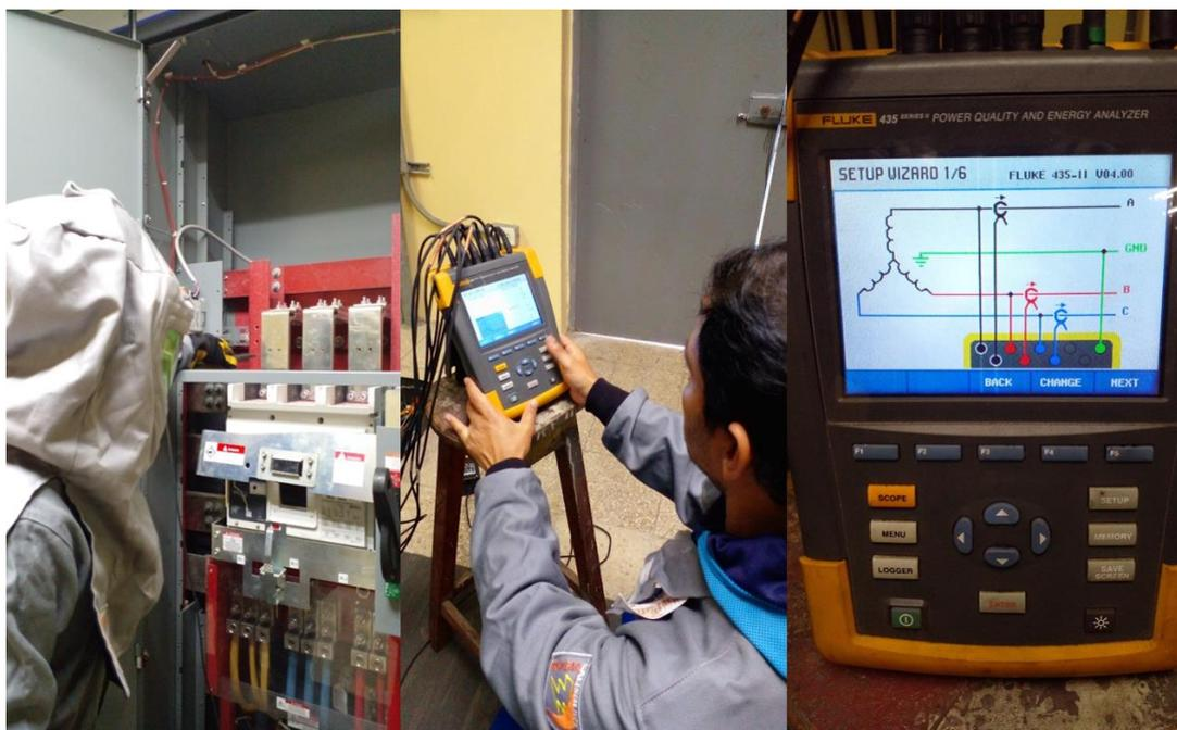
Figura 4.9 Instalación del Analizador de Calidad de Energía en el CCM de la planta Cautivo.
