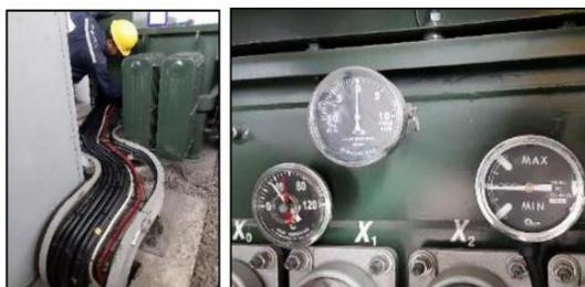
Limpieza de cables y bandeja, e Inspección de instrumentos de medición analógicos
