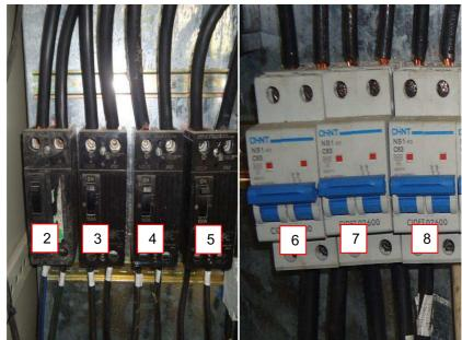
Figura 38. Orden de los breakers del panel de transferencia
