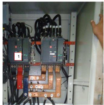
Figura 37. Breaker principal del panel de transferencia No1
