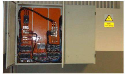
Figura 32. Panel de distribución auxiliar A14-15
