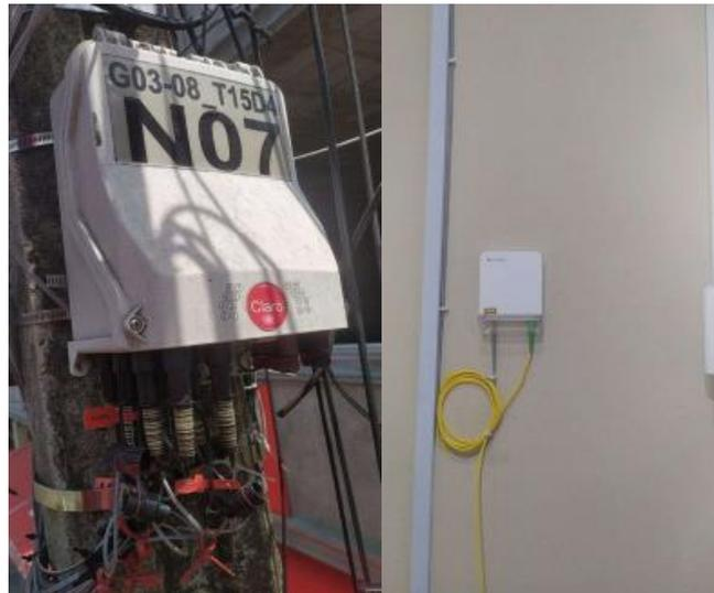
Figura 4: Planta externa y acometida interna
