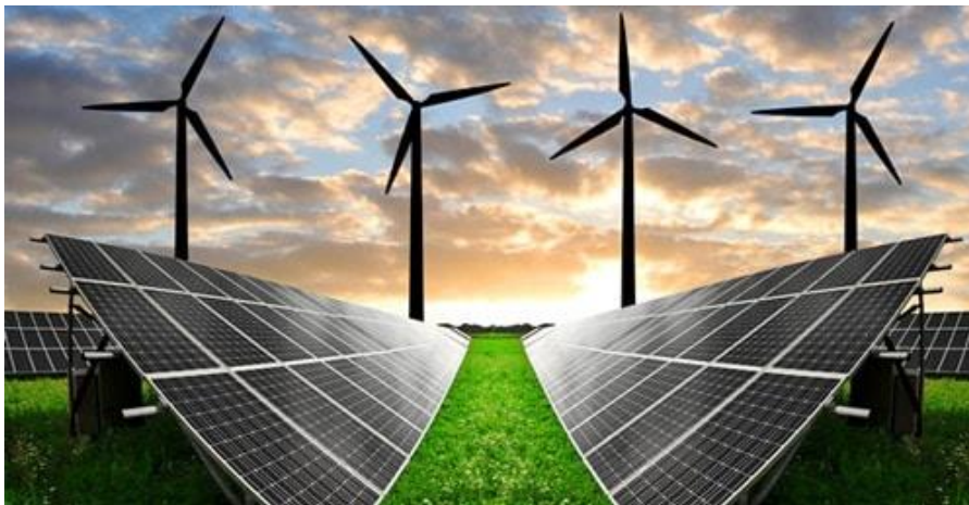
Figura 3: Aerogeneradores de eje horizontal y paneles fotovoltaicos (Abella, 2019)
