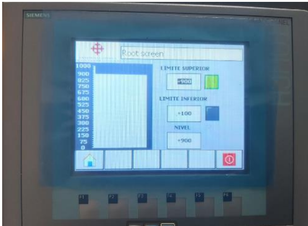
Figura 3. 78: Imagen de la pantalla HMI durante la ejecución del programa, nivel superior. Elaborado por: Autor.
