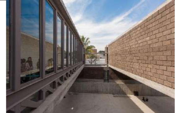
Figura 172: edificio primera y segunda planta
