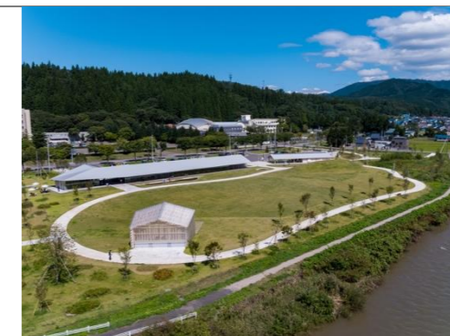
Figura 162 Patio exterior Fuente: Metalocus (2019)
