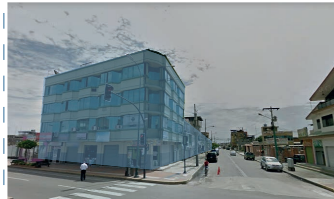
Edificaciones e hormigón Armado
