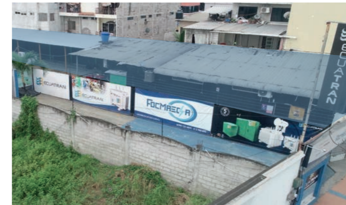
Proyectos bajos de estructura metálica
