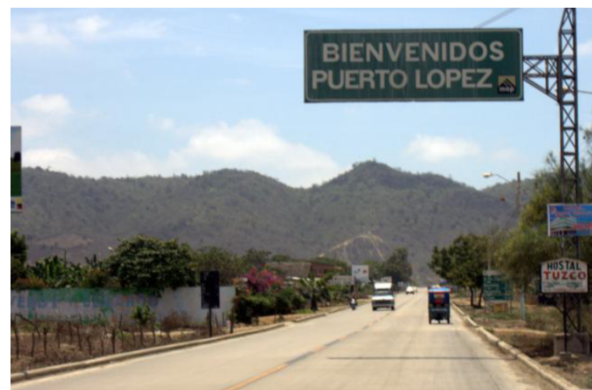
Figura 4.- Punto donde la carretera E-15 se transforma en Avenida Machalilla Ingreso a Puerto López.
