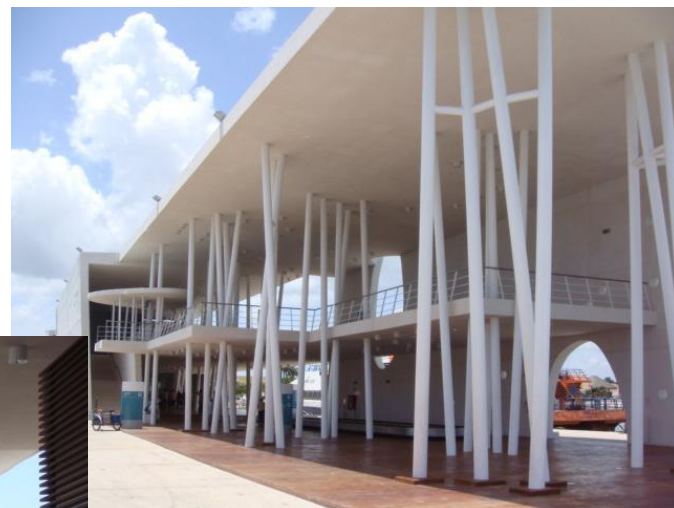
Figura 24.- Interiores de Terminal Fuente: (UG-Arquitectos, 2012)
