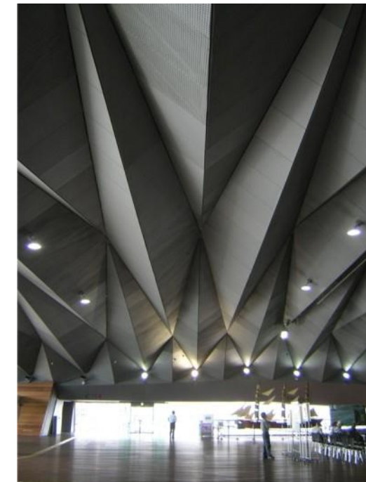
Figura 15.- Vista Interior de la cubierta. Fuente: (XXI, 2002)
