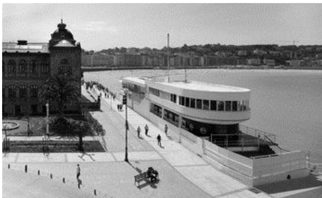
Figura 26.- Vista general de Club Náutico San Sebastián. Fuente: (Martínez, 2012)
