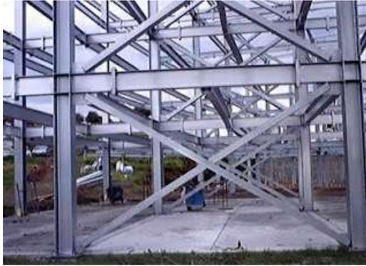
Figura 16. Tipo de construcción: Pórtico de acero laminado con diagonales (S2)
