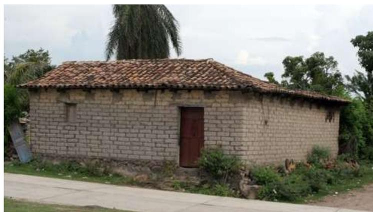
*Figura 8. Tipo de construcción: Mampostería sin Refuerzo (URM)*
