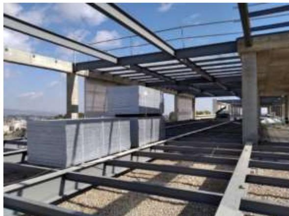
*Figura 10. Tipo de construcción: Mixta acero-hormigón (MX)*
