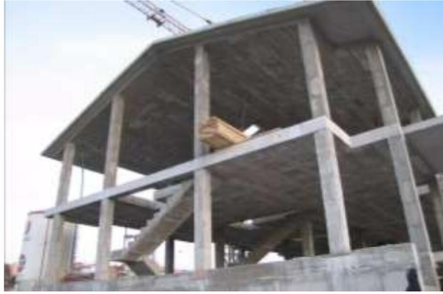
Figura 11. Tipo de construcción: Pórticos de hormigón armado (C1)
