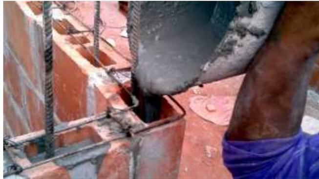
*Figura 9 Tipo de construcción: Mampostería Reforzada (RM)*
