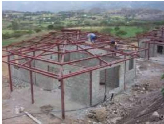
Figura 19 Tipo de construcción: Pórticos de acero con paredes de mampostería (S5)
