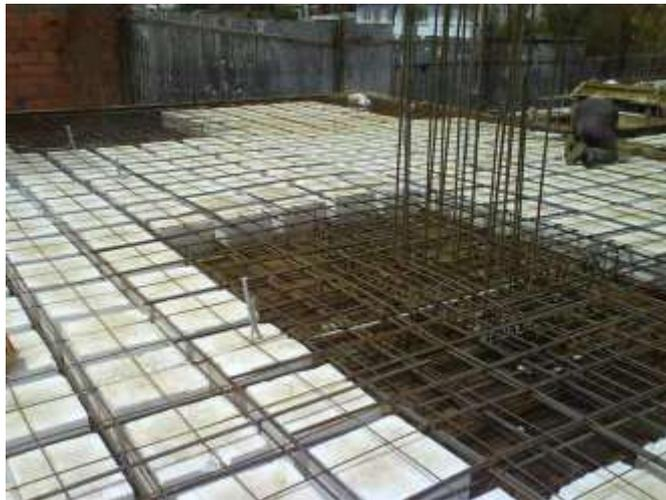
*Figura 3. Losa aligerada en dos direcciones*
