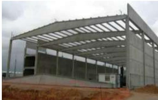
*Figura 14. Tipo de construcción: Hormigón armado prefabricado (PC)*
