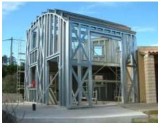
Figura 17. Tipo de construcción: Pórtico de acero doblado en frío
