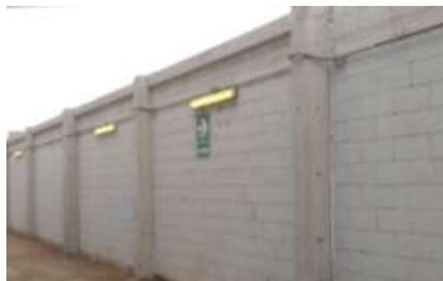
Figura 13. Tipo de construcción: Pórticos de hormigón armado con mampostería confinada sin refuerzo (C3):
