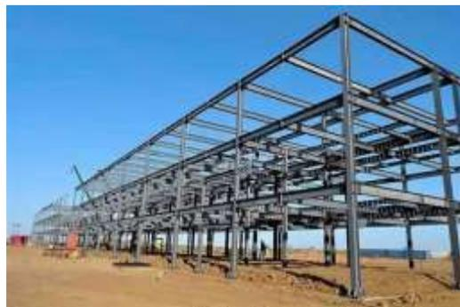
*Figura 15. Tipo de construcción: Pórtico de acero laminado (S1)*
