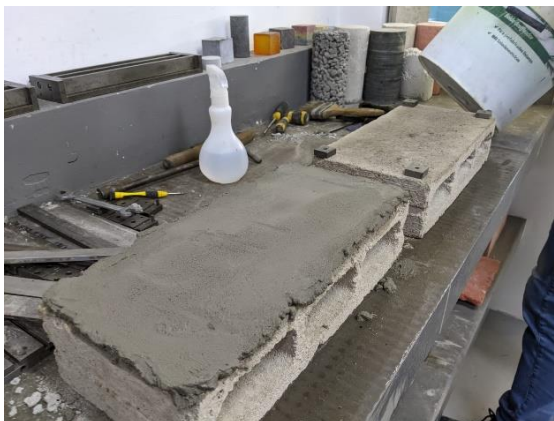
Figura 4 Acabado de enlucido
