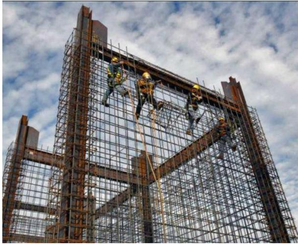
*Ilustración 13 Pórtico de acero laminado con muros estructurales de hormigón armado – S4*
