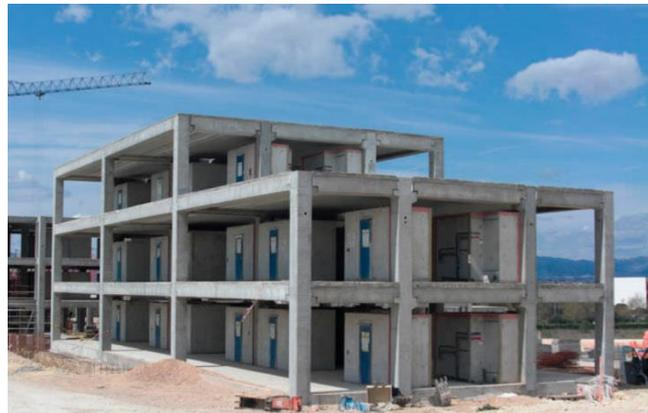
*Ilustración 7 Pórticos de hormigón armado – C1*
