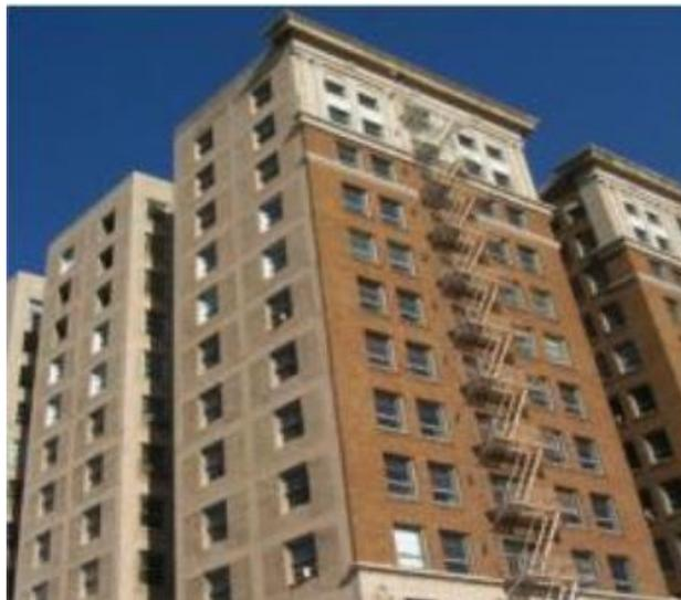
*Ilustración 9 Pórticos de hormigón armado con mampostería confinada sin refuerzo – C3*
