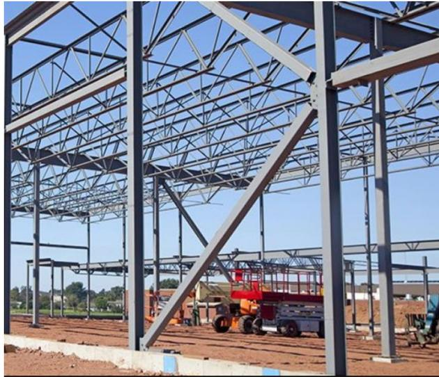
*Ilustración 12 Pórticos de acero laminado con uso de diagonales rigidizadores – S2*
