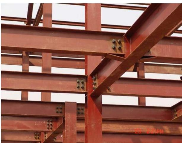
*Ilustración 11 Pórticos de acero laminado – S1*
