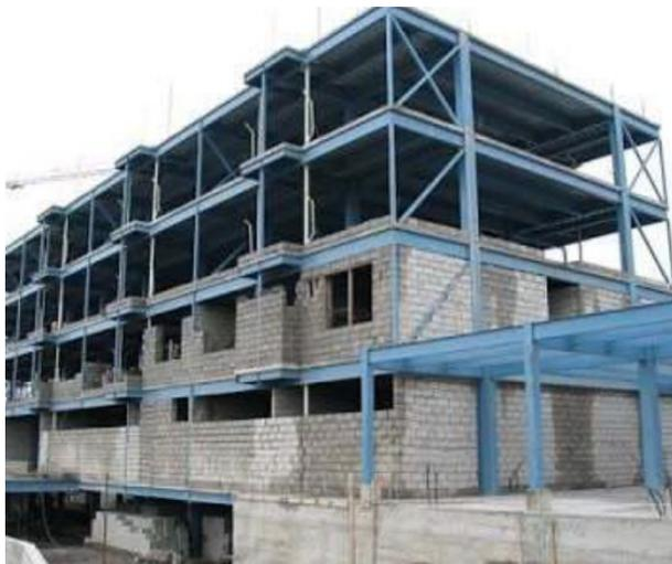
*Ilustración 14 Pórtico de acero con paredes de mampostería – S5*
