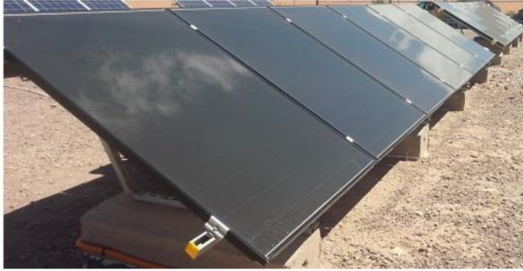
Figura 2. 6: Módulo de celdas solares fotovoltaica amorfa.
