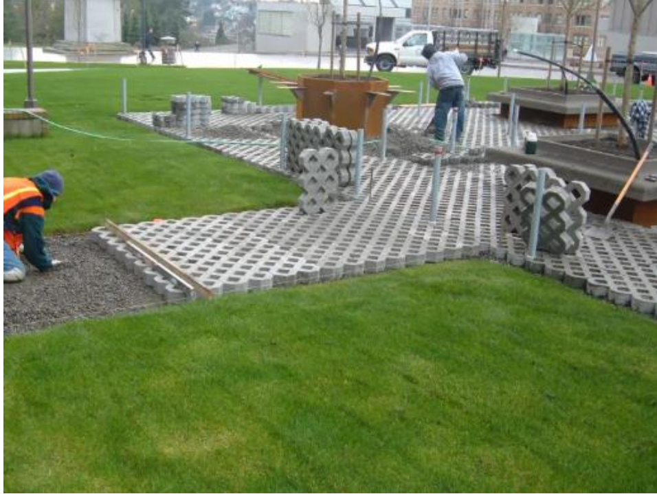
Ilustración 21. Instalación de bloques permeables. Obtenido de (SuD Sostenible, 2016)
