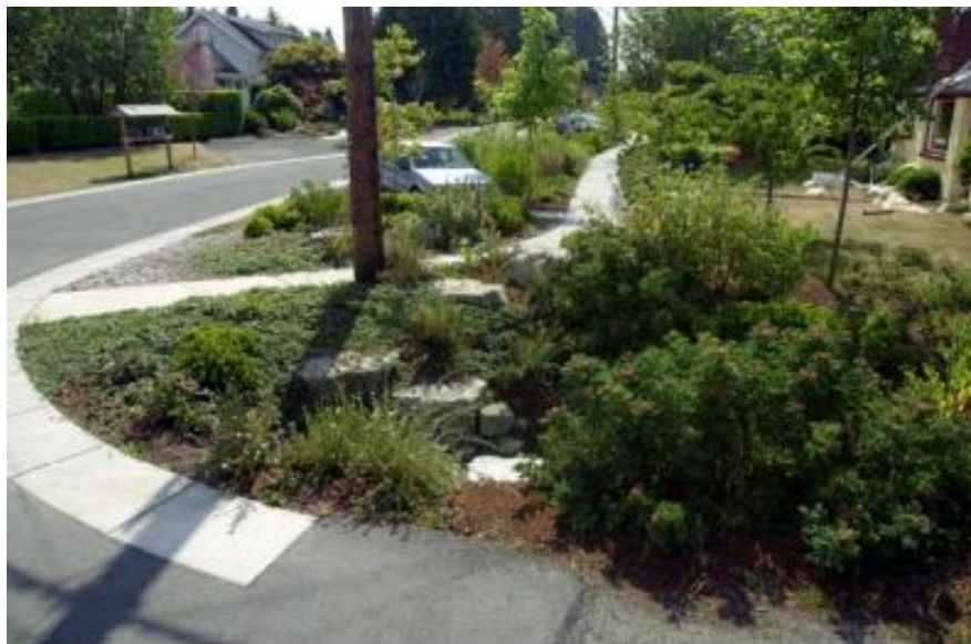
Ilustración 19. Ejemplo de celda de bioretención. Obtenido de (Capuccini, 2010)
