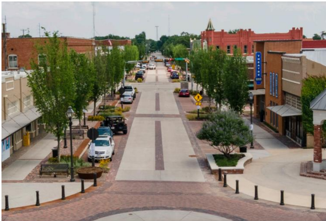
Ilustración 3. Adoquinado e instalación de celdas de bioretención laterales en Downtown Ennis, Texas. Obtenido de (Citygreen, 2019)
