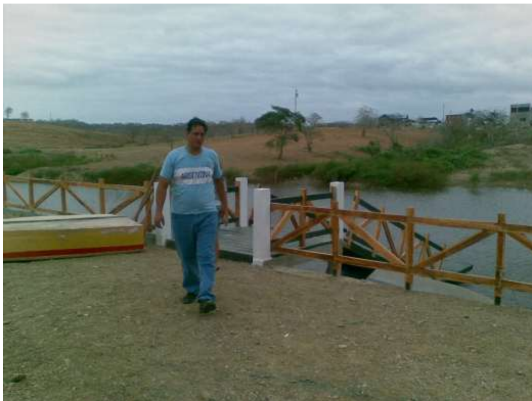
Figura 25 Vista del muelle
