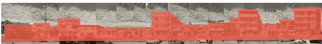
Visual 3 hacia el este se visualiza las culatas de edificaciones de uso mixto de hasta 3 niveles.
