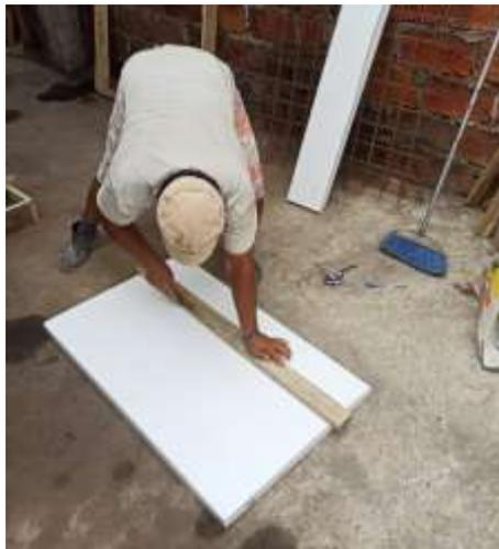
*Ilustración 7 Corte de los bloques de poliestireno a medida. Autoría Propia*
