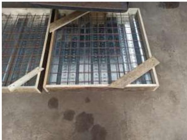
*Ilustración 12 Montaje de la losa de 12cm. Autoría Propia.*
