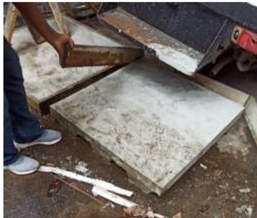
*Ilustración 19 Desencofrado de losa. Autoría Propia.*
