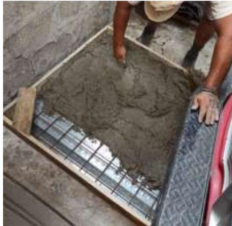
*Ilustración 18 Vertido de concreto sobre encofrado, Autoría Propia.*
