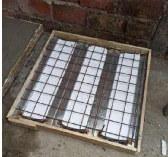
*Ilustración 11 Colocación de la malla electrosoldada.
