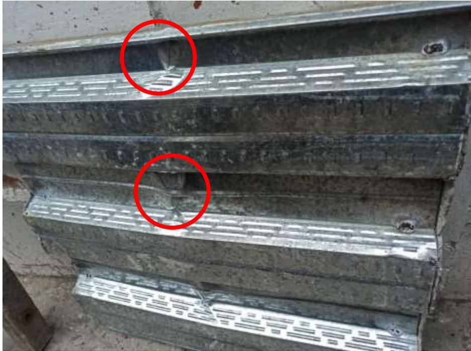
*Ilustración 41 Deformaciones visibles en el Steel panel. Autoría Propia*
