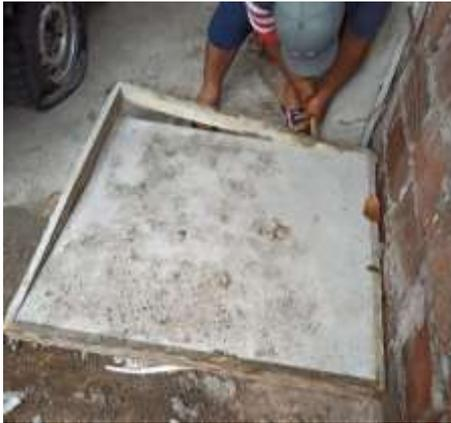
Ilustración 16 Desencofrado losa de 3cm.
