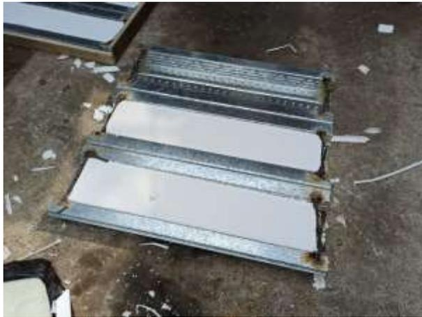
*Ilustración 9 Colocación de los bloques de poliestireno en los valles del Steel Panel. Autoría Propia.*
