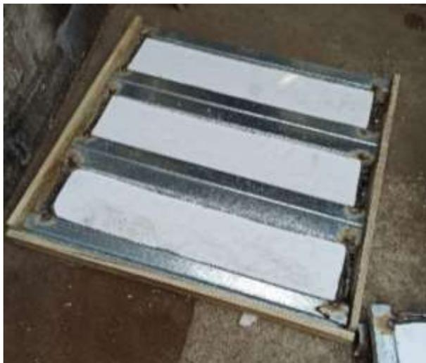
*Ilustración 10 Colocación del encofrado a cada losa. Autoría Propia.*
