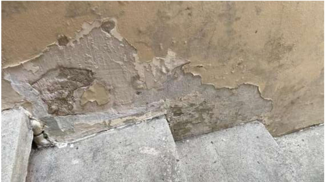
*Ilustración 60: Superficie sin enlucir que se utilizó para el ensayo esclerometría.*
