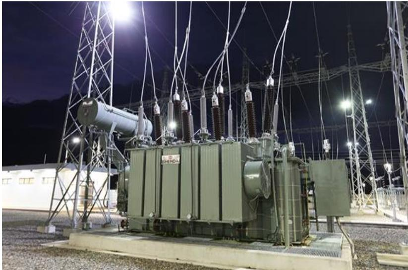
*Fig. 6 Subestación eléctrica 69kV/13.8kV. (Amado, 2022).*
