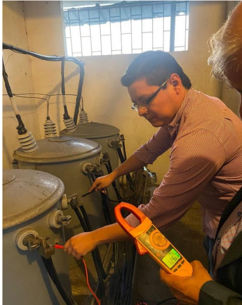
Figura 3. 20 Voltaje Nominal V_a
