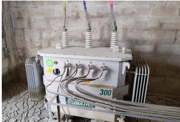
Figura 38 Transformador de 300 kVA trifásico
