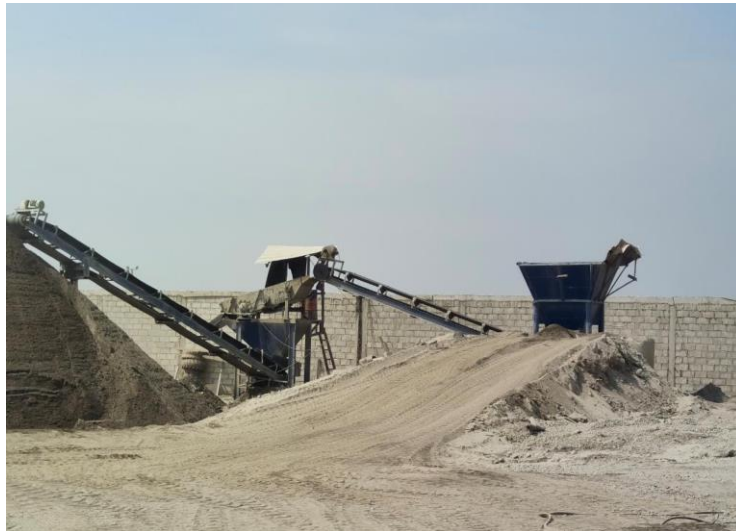
Figura 3 Banda transportadora de concreto premezclado
