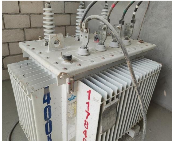
Figura 43 Transformador de 400 kVA trifásico
