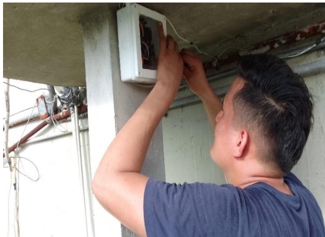
Figura 3.10: Instalación de la caja protectora para el equipo Elaborado por: El Autor
