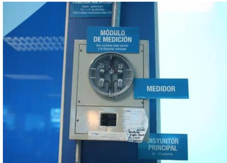
Figura 2. 6 Elementos de tablero de medición
