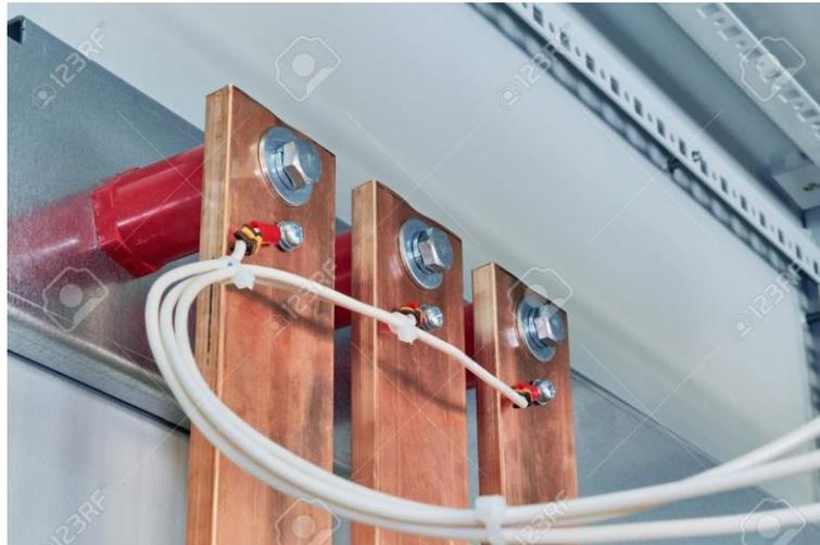
Figura 2. 4. Barra colectora trifásica
