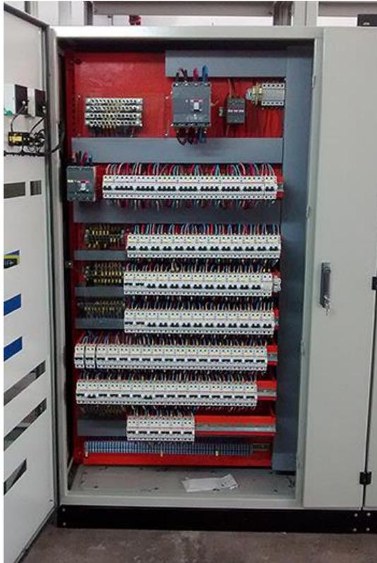
Figura 2. 16. Tablero de protección DC subestación
