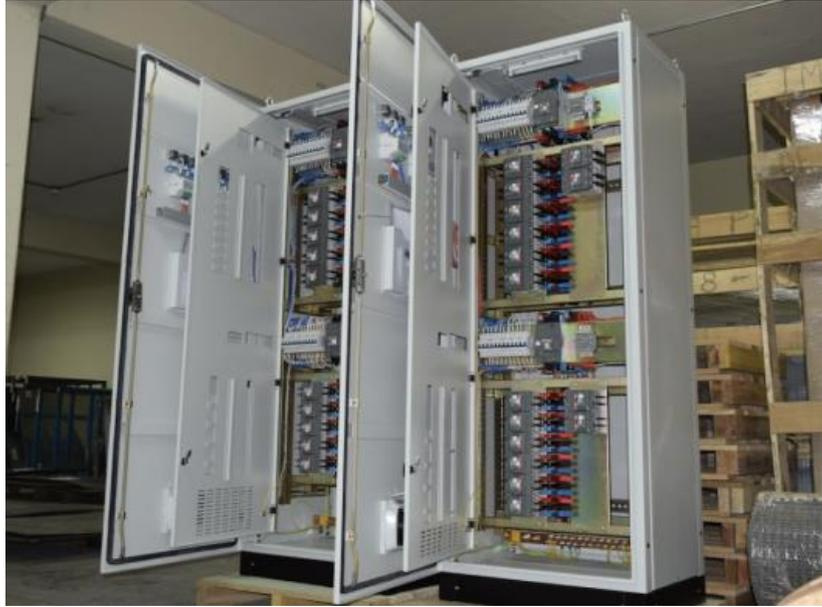
Figura 2. 15. Tablero de protección AC Subestación
