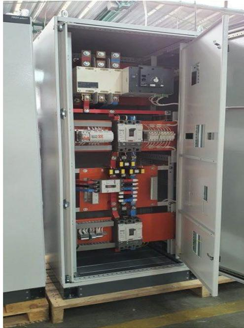
Figura 2. 21. Tablero de transferencia automática con ATYS P
