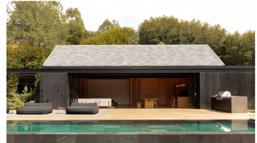
Imagen 13: Fachada de la casa dos aguas.
