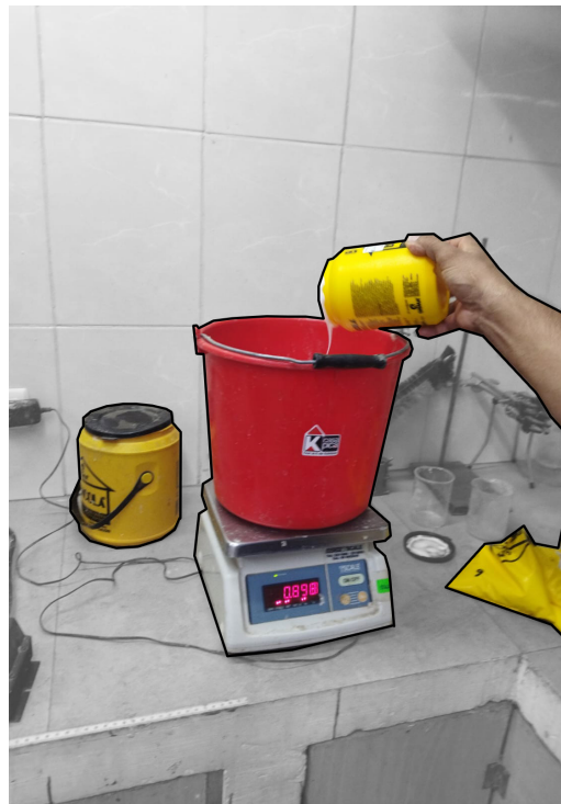
Figura 107. Colocación de adhesivos
