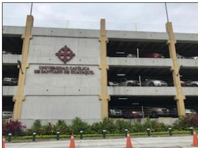
Figura 3 Edificio de parqueos en funcionamiento culminado la obra.
