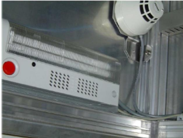
**Figura 3.7: Linterna y sensor de humo del gabinete.**
