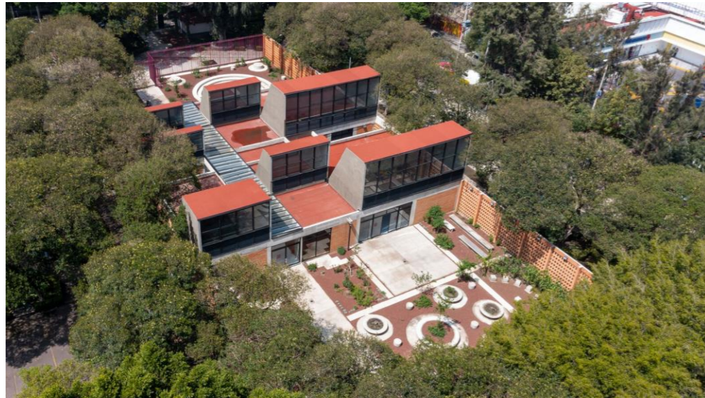
Figura 121. Centro comunitario Pilares Valentín
