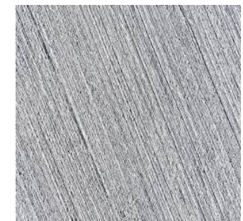
Figura 55: Hormigón barrido para piso.
