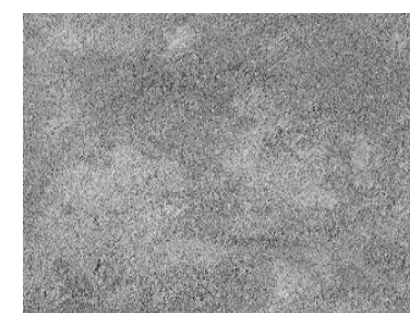
Figura 31: Hormigón crudo pulido
