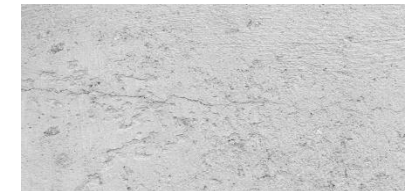
Figura 29: Hormigón crudo pulido.
