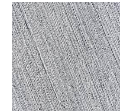
Figura 50: Piso de hormigón pulido
