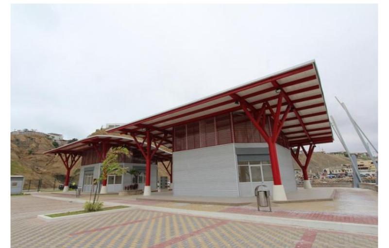
Imagen Estructura de Cubierta con material metálico.
