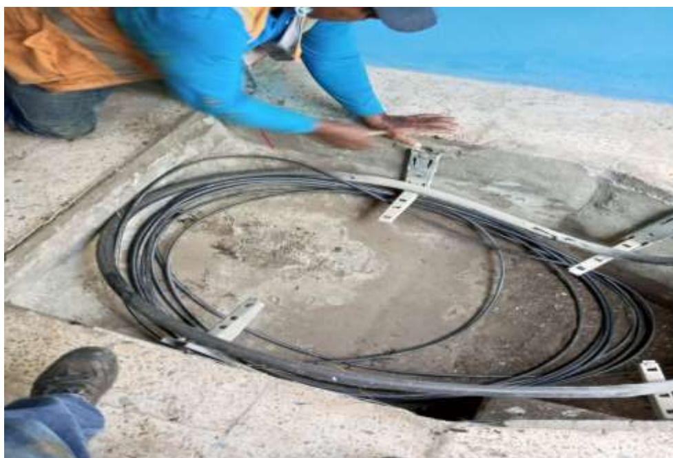
Figura 3.8 Revisión de Cámara Telefónica en Nodo
