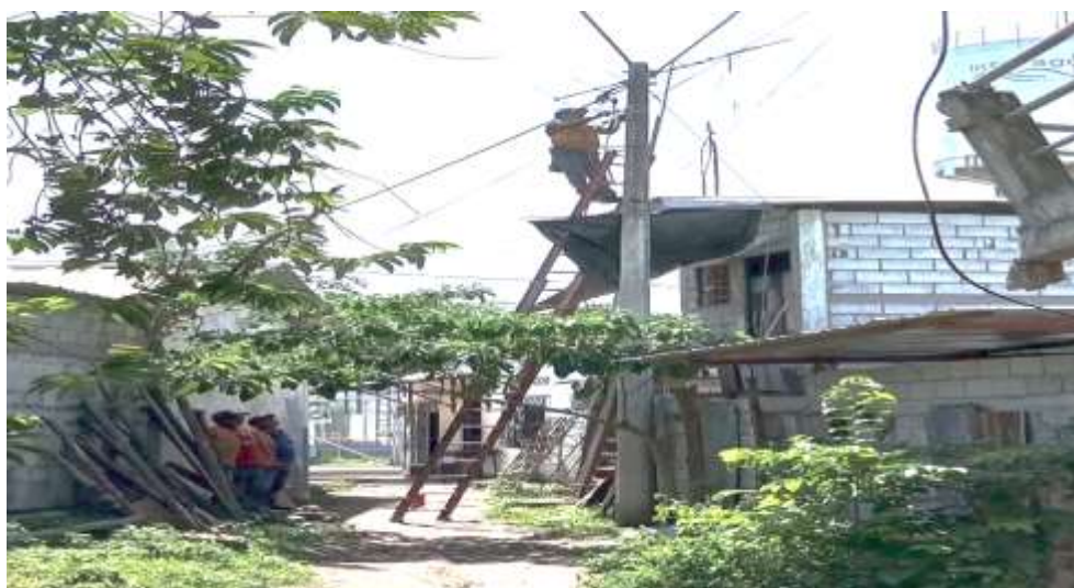
Figura 3.5 Revisión de Infraestructura de Postes
