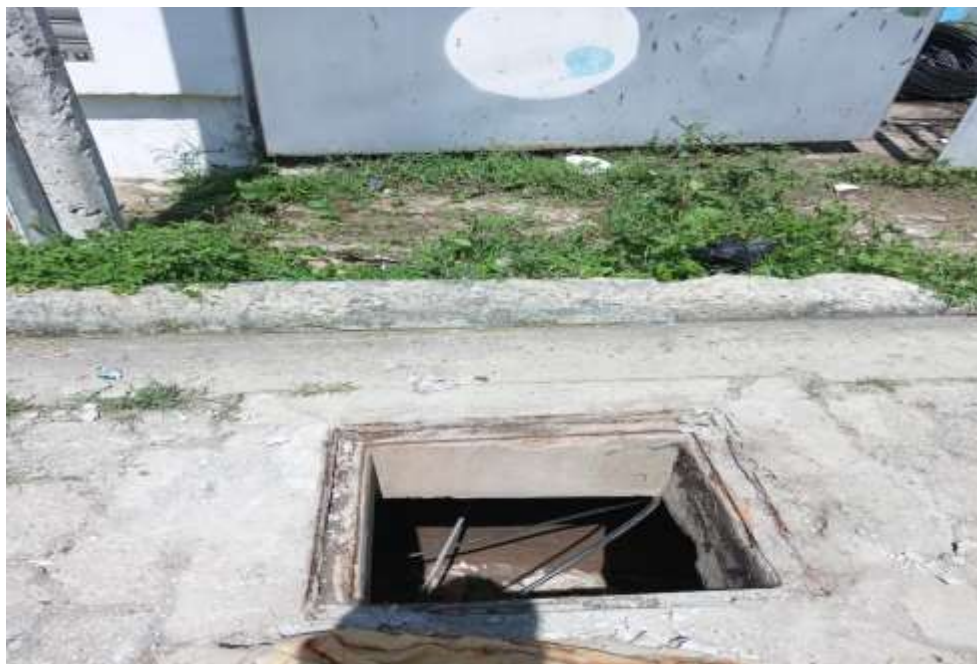
Figura 3.7 Revisión de Infraestructura en Pozo
