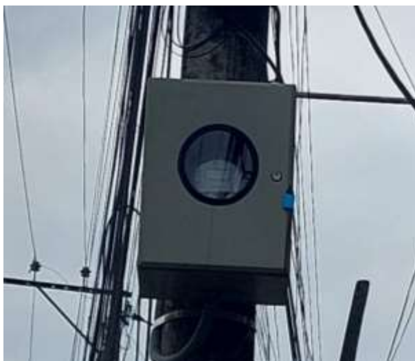
Figura 3.10 Medidor de voltaje de poste.
