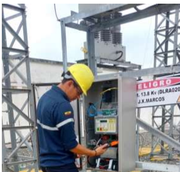
Figura 3.7 Medición de intensidad de parámetros en el tablero de control del reconectador de cabecera.
