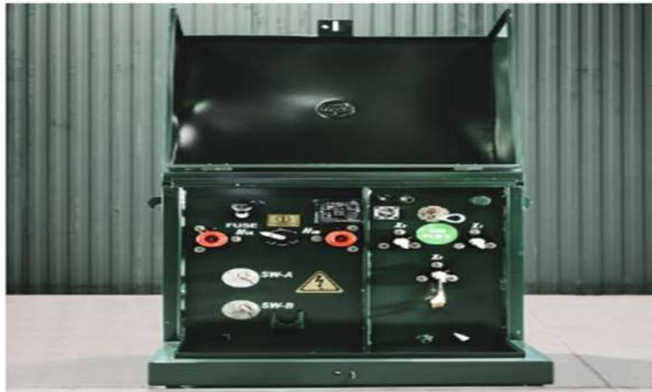
**Figura 2.24:** Transformador tipo Pad Mounted Monofásico
