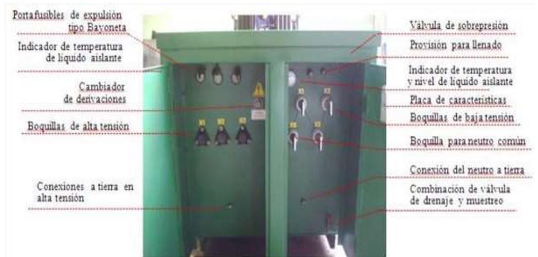
**Figura 2.27:** Transformador tipo Pad Mounted Trifásico
