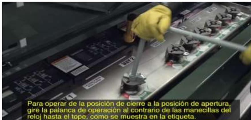
**Figura 2.9:** Operación manual Switch Vista
