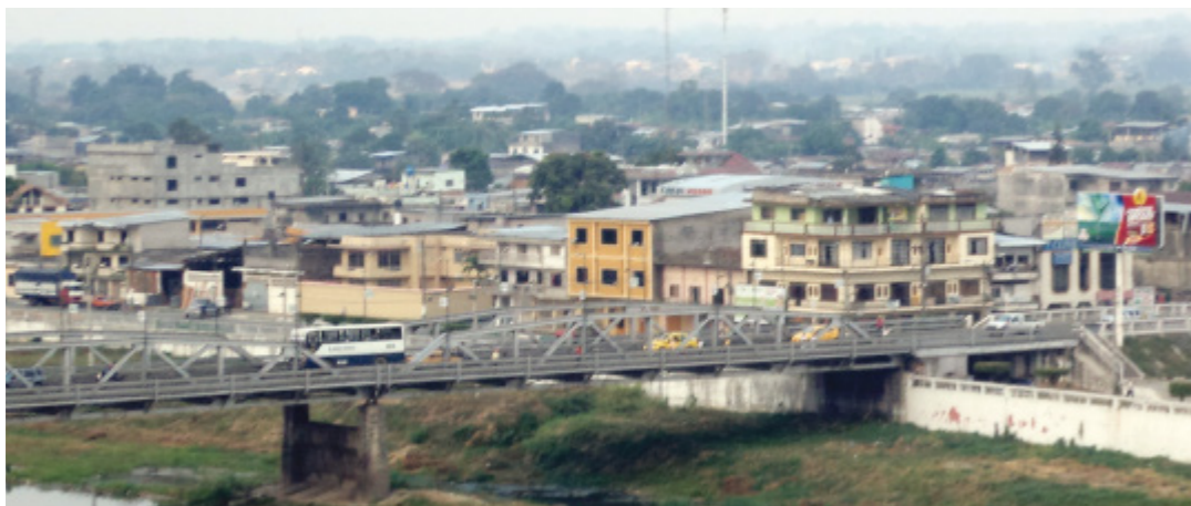
Figura 56: Puente Velasco Ibarra Fuente: PDOT GAD Quevedo (2014)
