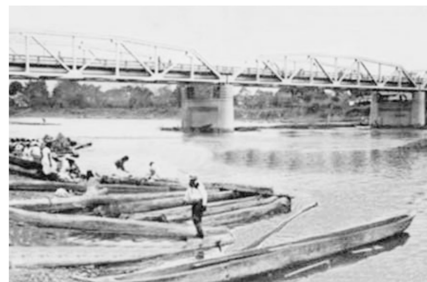
Figura 7: Puente Velasco Ibarra de la Ciudad de Quevedo 1960 Fuente: “Fotos históricas de Quevedo”(2014)
