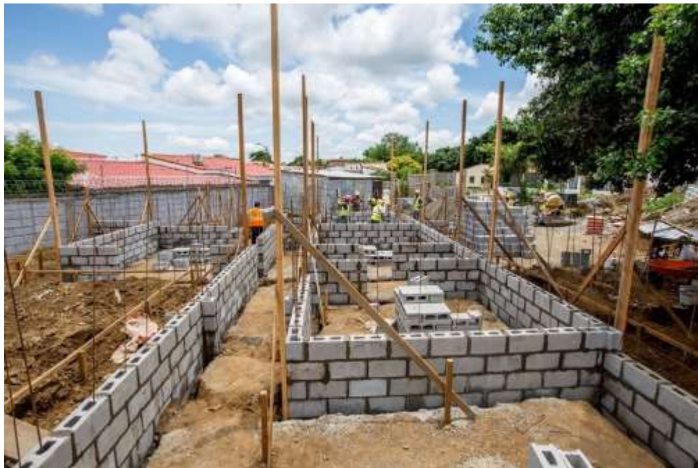
Ilustración 34. Mampostería reforzada (RM). Tomado de (GC Construcciones, 2017).
