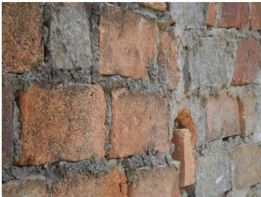
Ilustración 33. Mampostería sin refuerzo. Tomado de (Vargas, 2019).
