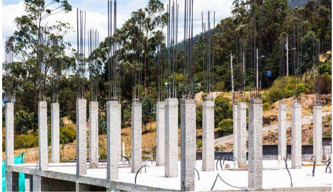
Ilustración 2. columnas en proceso constructivo. Tomada de (Albañiles Trust Service, 2022).
