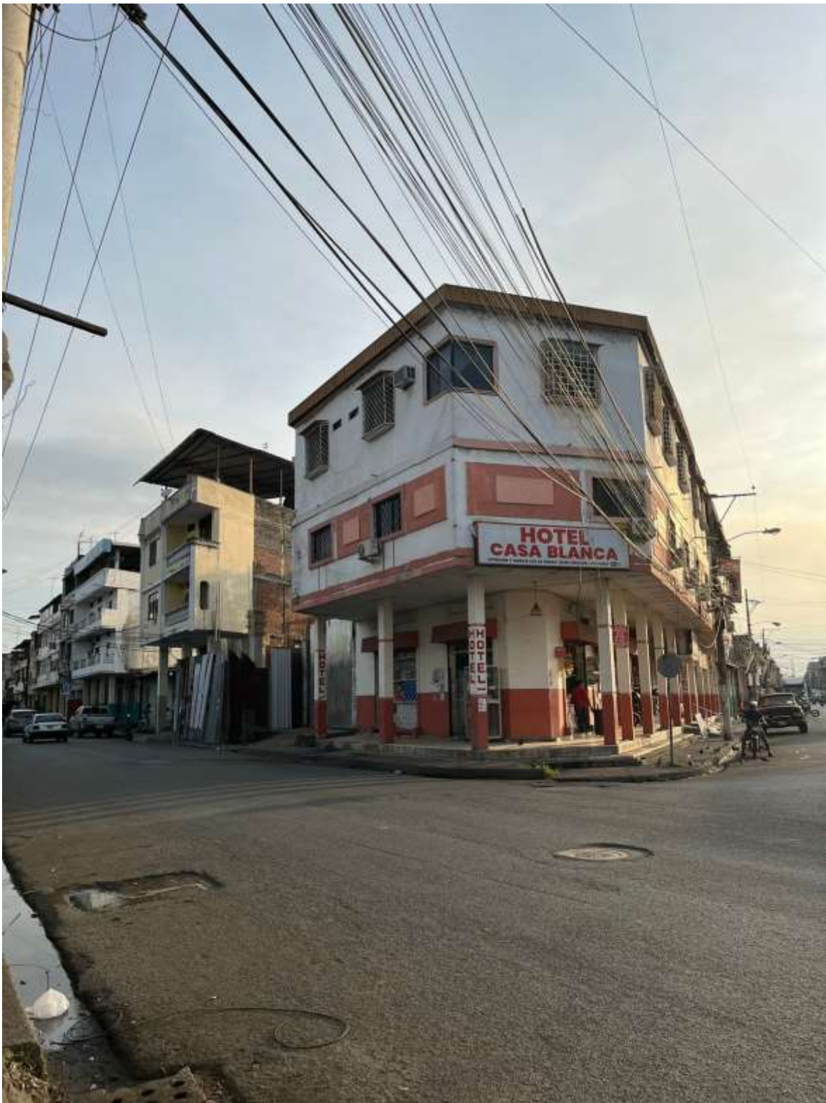
Ilustración 57. Edificio con irregularidad en planta, ejes estructurales no paralelos. Fuente: Elaboración propia.
