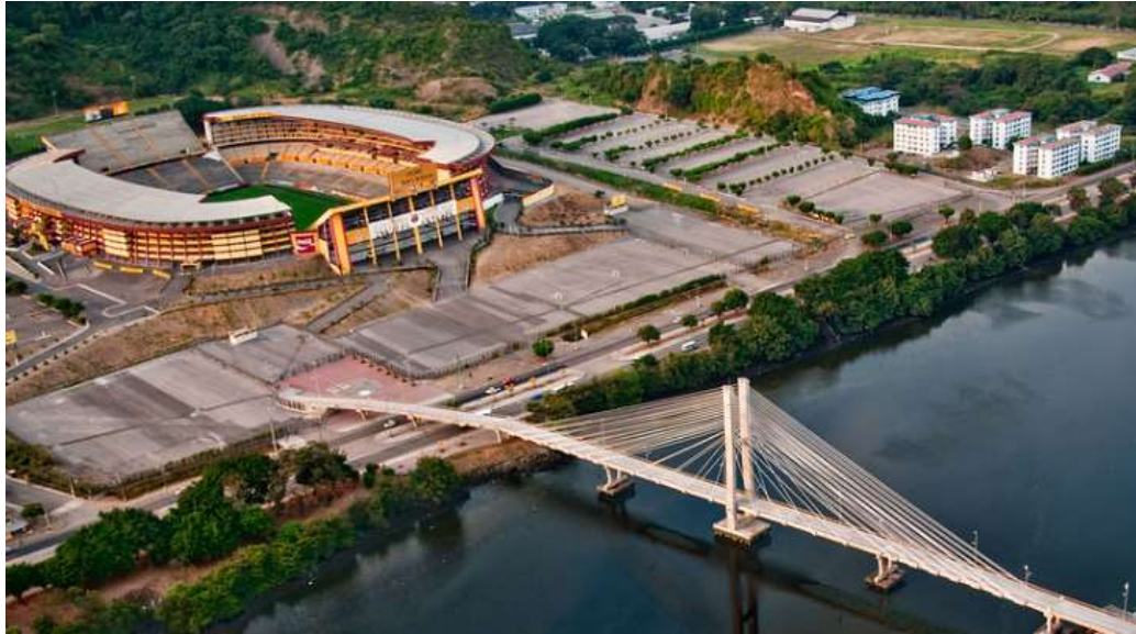
Ilustración 5. Puente peatonal atirantado del estadio de Barcelona Sporting Club, ciudad de Guayaquil – Ecuador. Tomada de (Borja, 2010).
