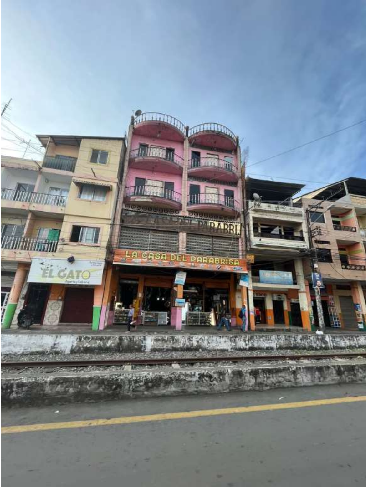
Ilustración 55. Edificaciones con peligro de golpes con edificios adyacentes. Fuente: Elaboración propia.
