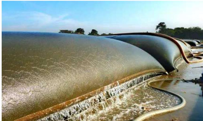
*Nota.* Tomado de *Dsecación de Geotubos*, por XY Geosynthetics, 2019., <https://es.xygeosynthetics.com/geofabriform/geotube/geotube-dewatering.html>
