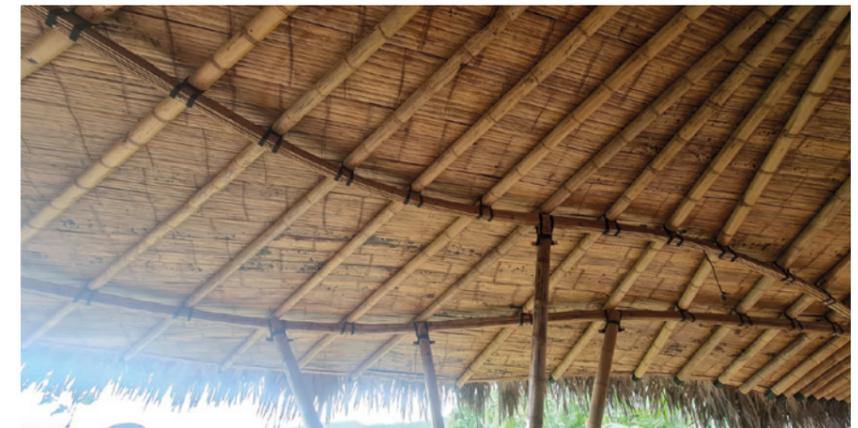
Imagen 13. Cubierta de bambú vista desde abajo. Visita de aprendizaje a una construcción de la zona
