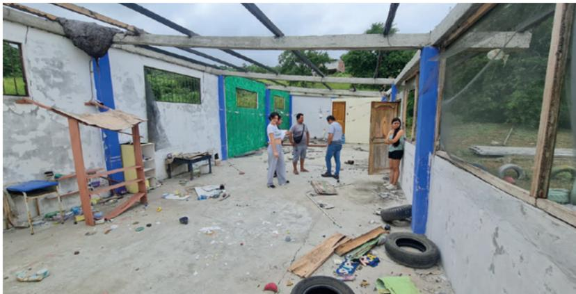
Imagen 33. Vista interior derecha del aula de inicial. Estado actual de deterioro posterior al terremoto.
