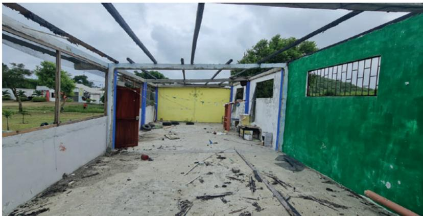
Imagen 34. Vista interior izquierda del aula de inicial. Estado actual de deterioro posterior al terremoto.
