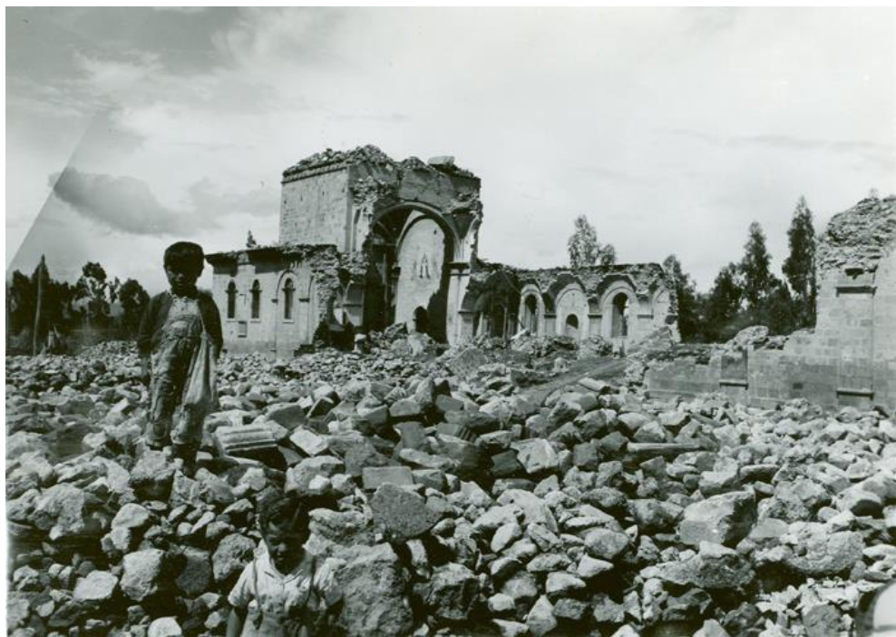
Figura 18. Terremoto del 5 de agosto de 1949.
