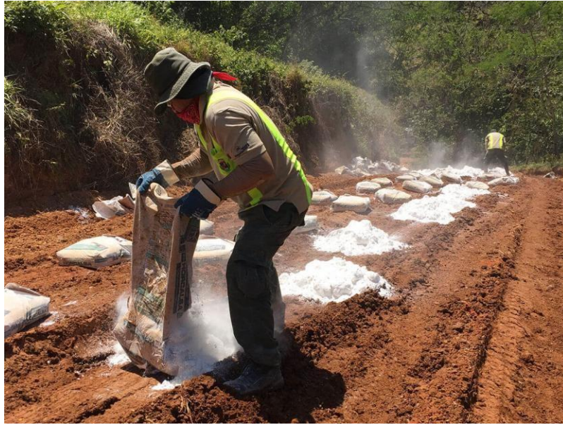
Figura 56: Implementación de cal en suelos de alta plasticidad.
