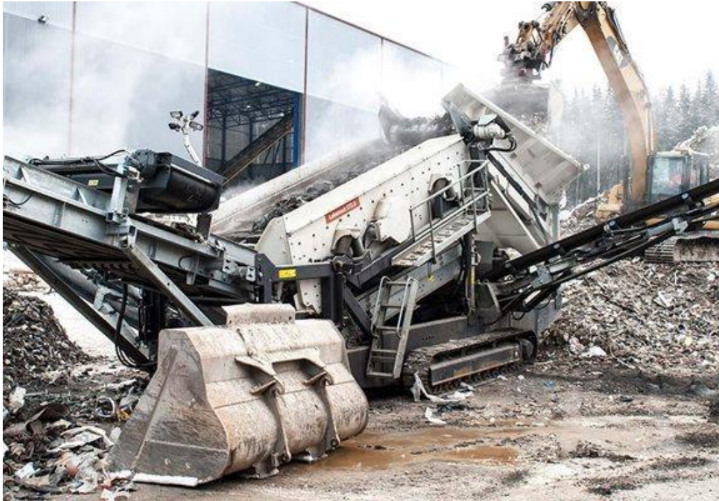
Figura 60. Reciclaje de residuos de construcción y demolición aplicando medidas de reciclaje y sostenibilidad.
