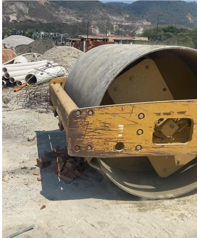
Figura 70. Trituración de desechos de materiales de construcción.
