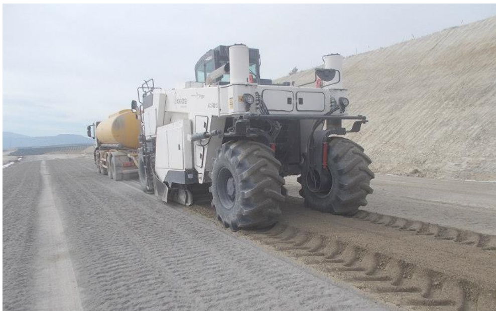
Figura 57: Estabilización de suelos con cemento.
