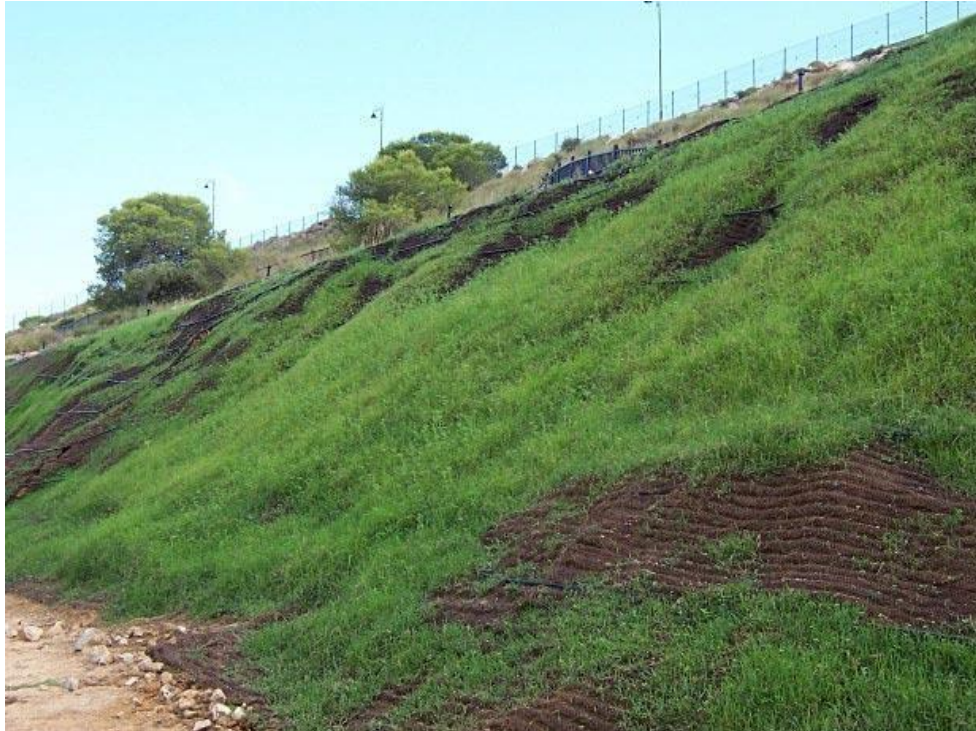
Figura 41. Control de erosión del suelo con cobertura vegetal.
