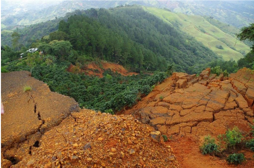
Figura 31. Zona arcillosa susceptible a deslizamientos.
