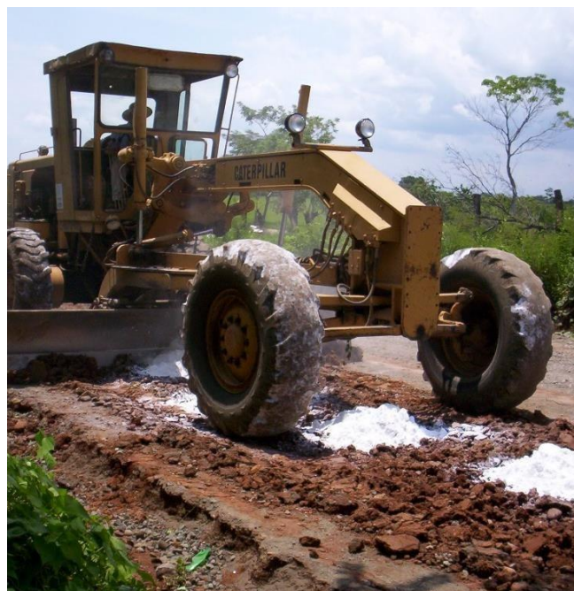
Figura 55. Utilización de cal para estabilizar suelos arcillosos.
