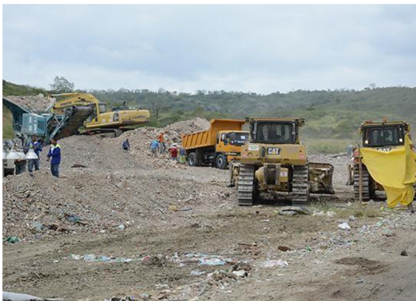
Figura 11. Escombrera "La Solita" recibiendo escombros del sismo de Manabí
