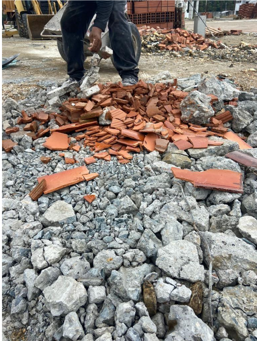
Figura 67. Acumulación de residuos de materiales de construcción para trituración.
