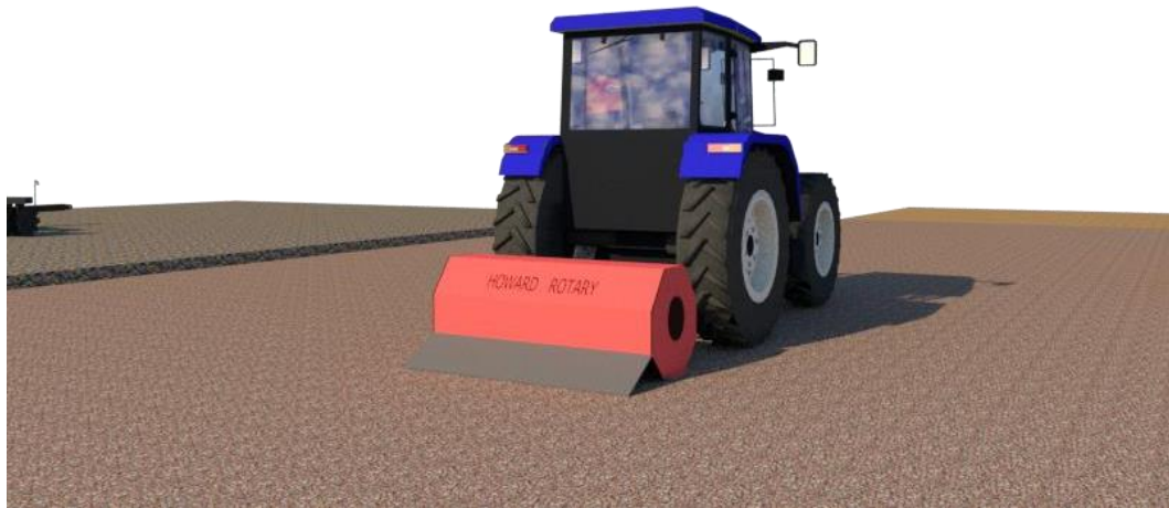
Figura 108. Pulverizado del material con el uso de rotavator
