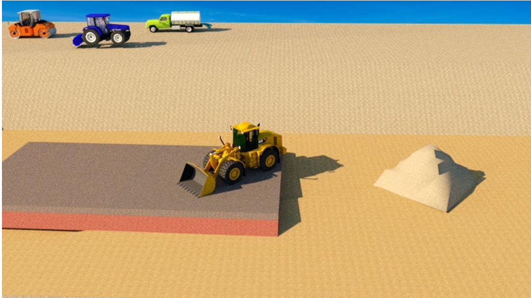
Figura 102. Ejecución de mezclado en plaza de trabajo provisional
