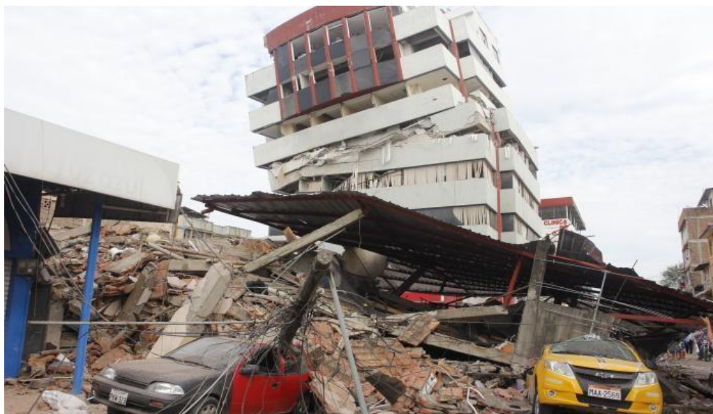
Figura 10. Colapso de estructuras después del sismo del 2016 en Manabí.
