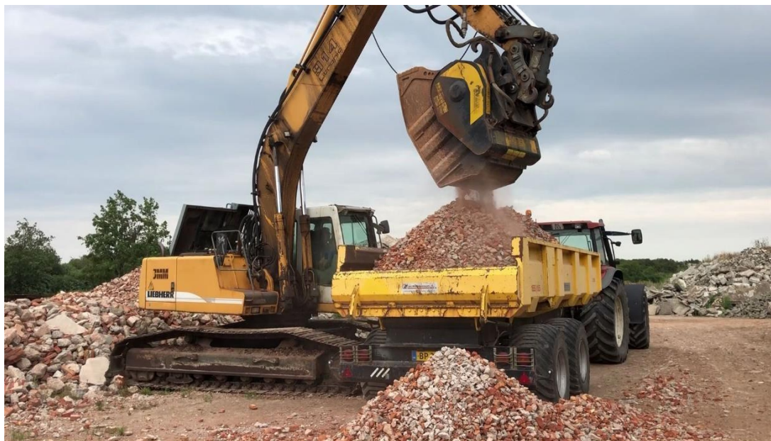
Figura 98. Triturado de material de escombros con excavadora con cuchara trituradora situada en el botadero.
