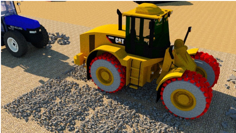
Figura 105. Triturado de la mezcla con rodillo pata de cabra
