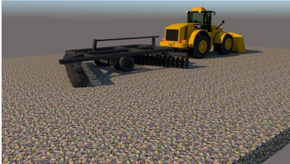
Figura 104. Uso de la rastra agrícola para elevar el material grueso para ser triturado
