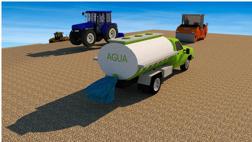
Figura 109: Hidratación del material con tanquero para correcta compactación
