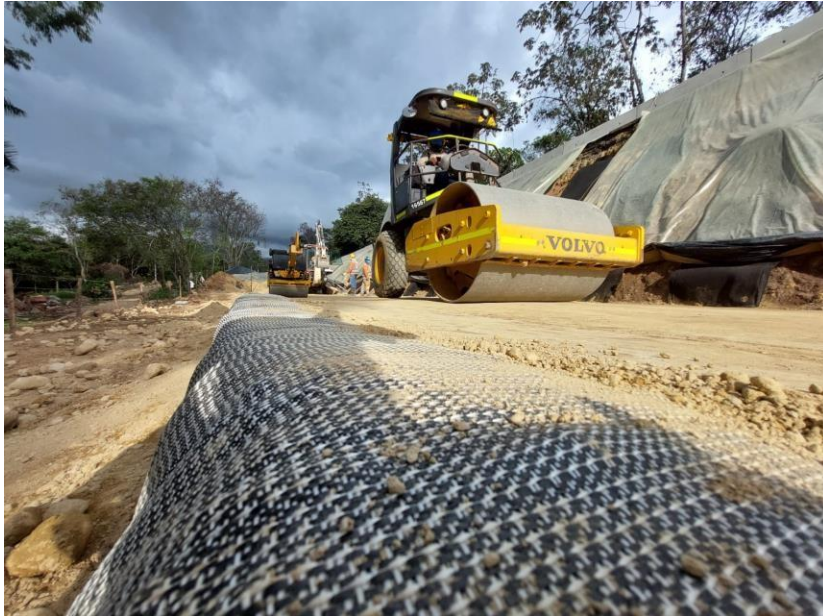
Figura 52. Geotextil Tejido diseñado y fabricado con una estructura única que le permite ser utilizado para reforzar, separar y drenar.
