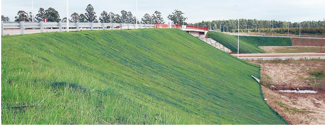
Figura 42. Aportación de estabilidad y estética de la cobertura vegetal al terraplén.
