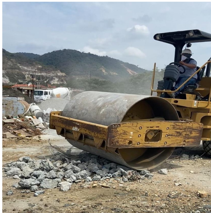
Figura 69. Trituración de desechos de materiales de construcción utilizando rodillo liso.
