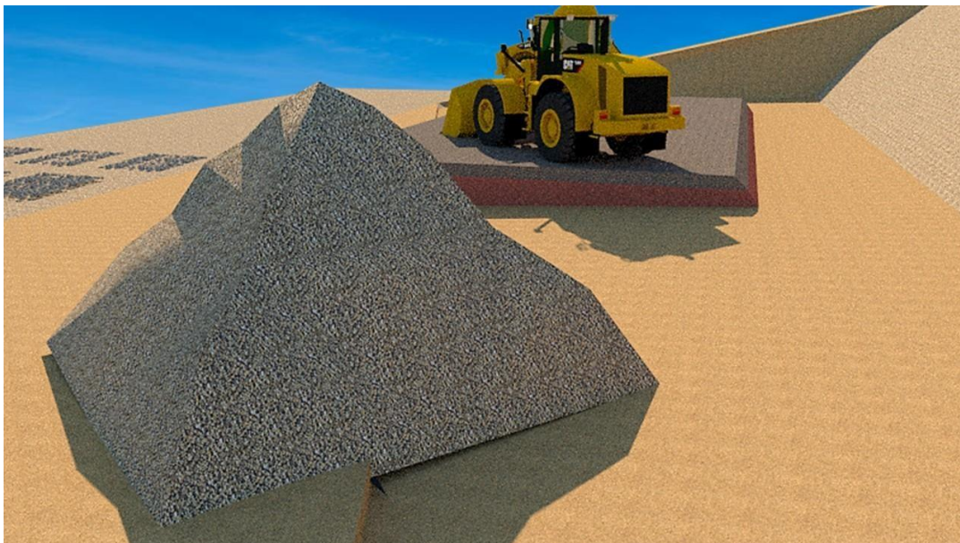
Figura 101: Tendido del material de la mezcla en plaza de trabajo definitiva con cargadora frontal
