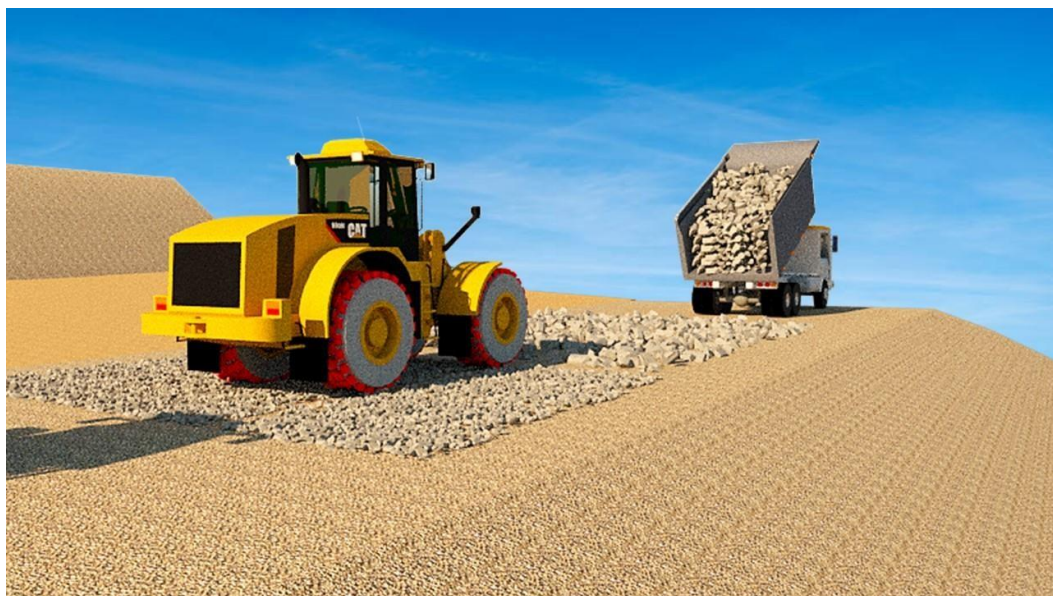
Figura 103: Trituración del rodillo pata de cabra
