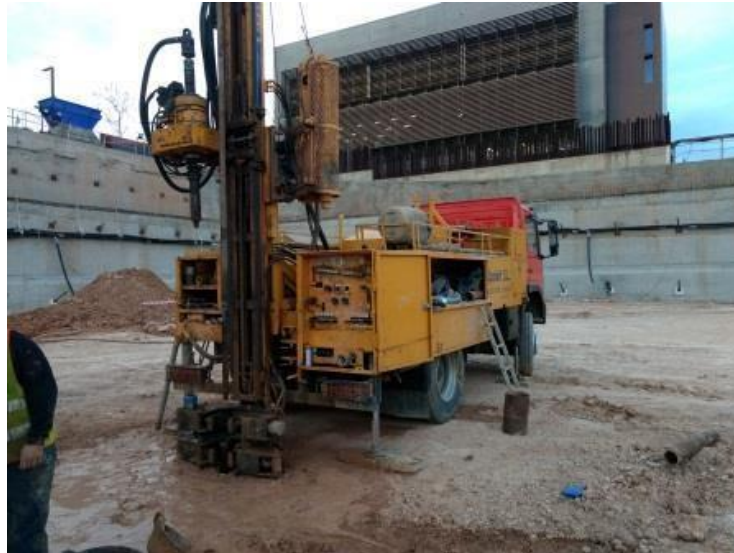
Figura 46. Prueba de perforación a rotación y recuperación de testigos.
