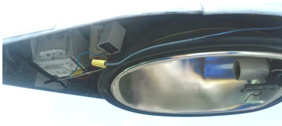
Figura 27 Luminarias de Sodio de 400 W.
