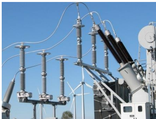
Figura 2.3. Pararrayos de 69 KV
