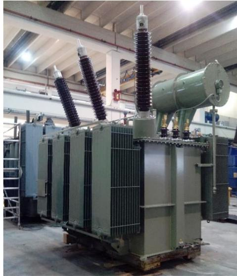
**Figura 2.5.** Transformador de poder 69/13.8 kv
