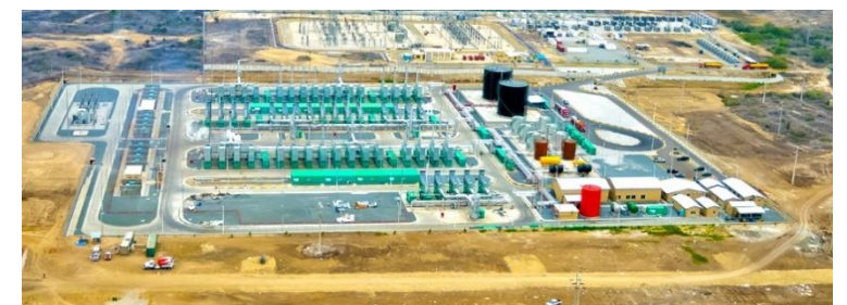
Figura 50. Central Eléctrica de Santa Elena. Fuente: (2014), Central proveedora de la energía en la provincia. [Fotografía] Recuperado de: Galería fotográfica de Google Earth.
