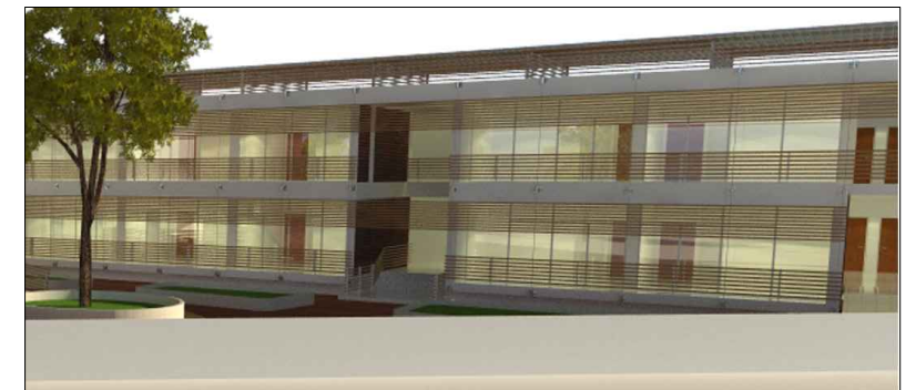
Elementos de celosía y pasamano
