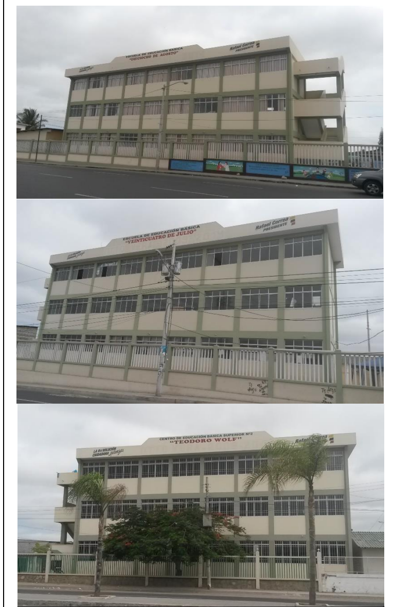
Figura 25. Unidades Educativas: Colegio Dieciocho de Agosto, Colegio Veinticuatro de Julio, Colegio Teodoro Wolf. Fuente: Autor (2014), Mejora en las edificaciones de la educación. [Fotografías]
