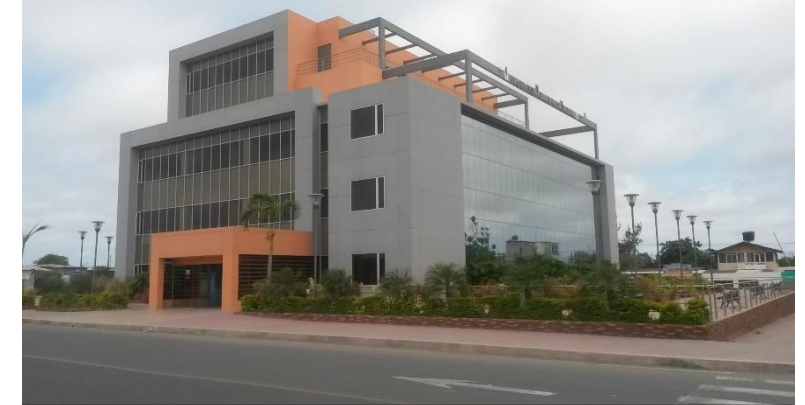
Figura 42. Registro Civil, Gobierno Provincial de Santa Elena, Consejo de la Judicatura. Fuente: Autor (2014), Edificios intervenidos y desarrollados actualmente en el cantón Santa Elena. [Fotografías]
