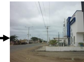
Figura # 55: Línea de media tensión y alumbrado público. Autor: Rodríguez & Rojas (2014).
