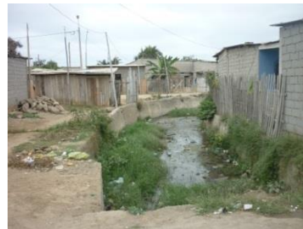
Figura # 64: Canal de Desagüe hacia el norte del terreno. Autor: Rodríguez & Rojas (2014).
