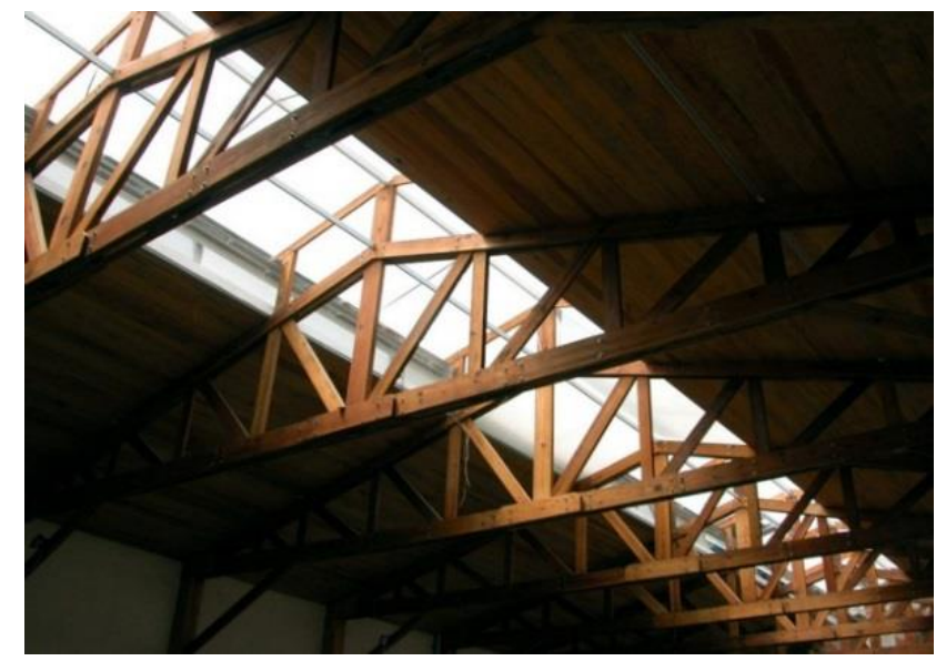
Figura # 99: Estructura de cubierta – Galería Kurimanzutto. Fuente: Rosenbleuth (2012).
