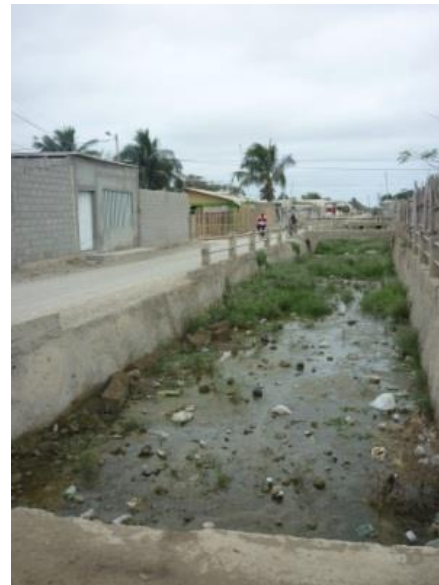
Figura # 65: Canal de Desagüe hacia el sur del terreno. Autor: Rodríguez & Rojas (2014).
