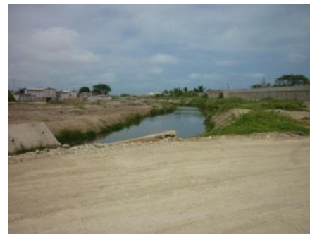
Figura # 63: Canal de Desagüe. Autor: Rodríguez & Rojas (2014).
