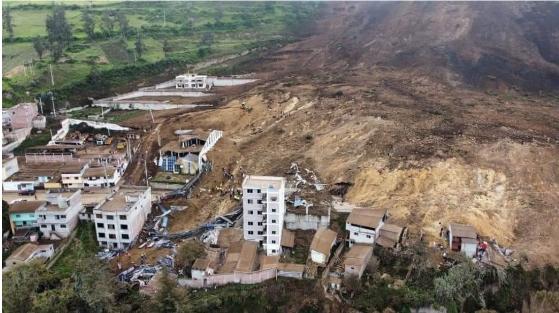
Figura 59. Deslizamiento en Alausí
