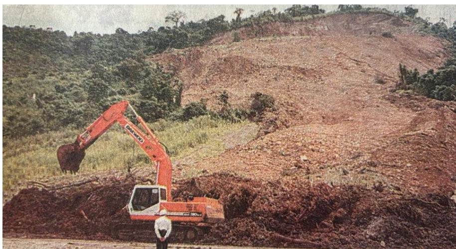
Figura 2. Retroexcavadora del Municipio realizando trabajos de desalojo del material deslizado
