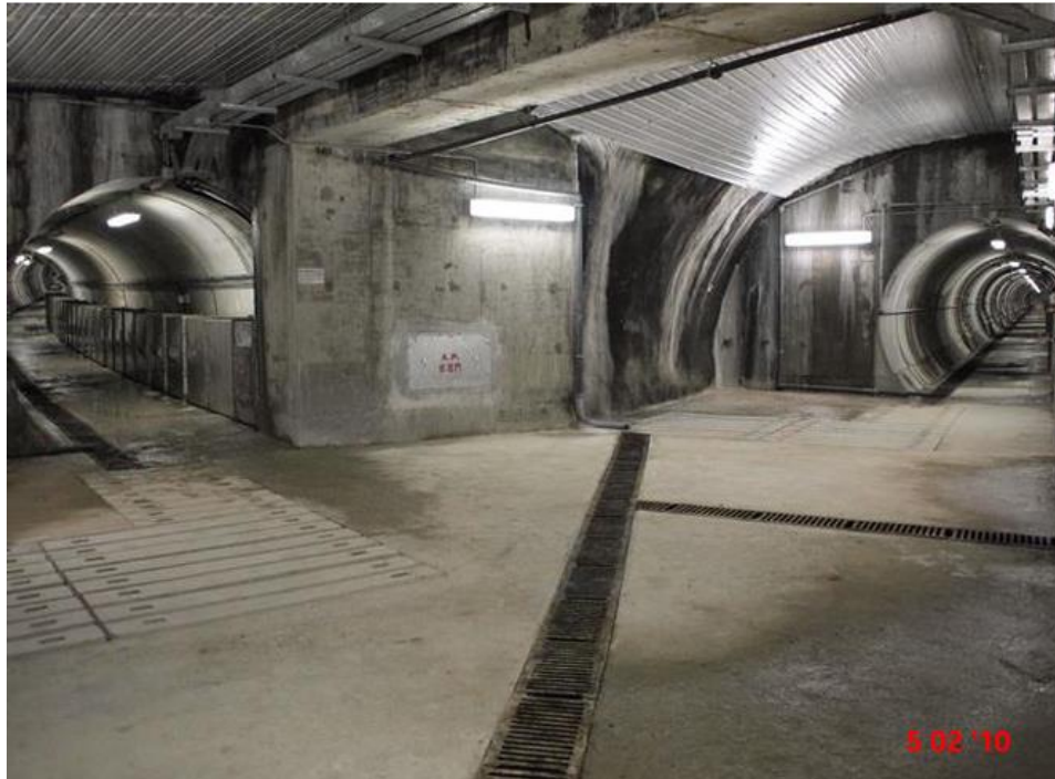
Figura 84. Sistema de drenajes subterráneos
