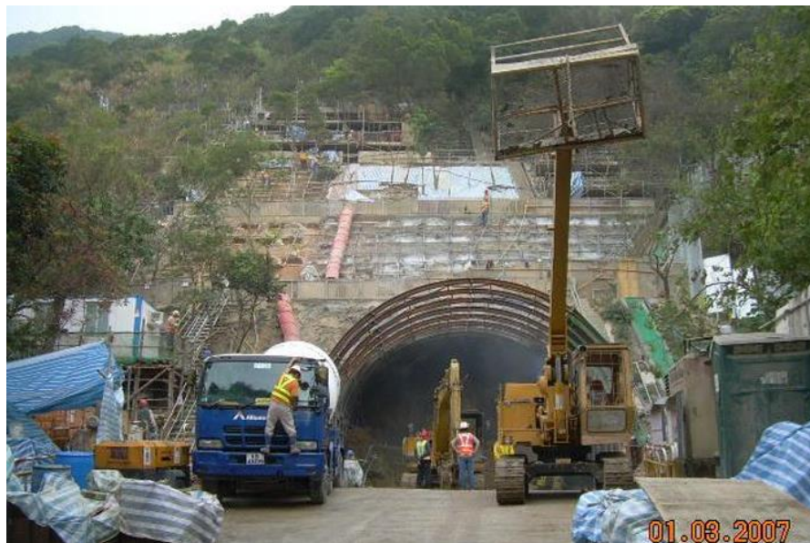
Figura 83. Inicio de la construcción de la entrada a las galerías de drenaje del cerro Po Shan
