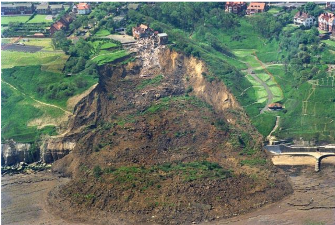
Figura 51. Se observa un deslizamiento rotacional en el que la superficie de deslizamiento es curva (a menudo como la superficie de una cuchara); esto se conoce como ruptura lítrica o superficie de deslizamiento
