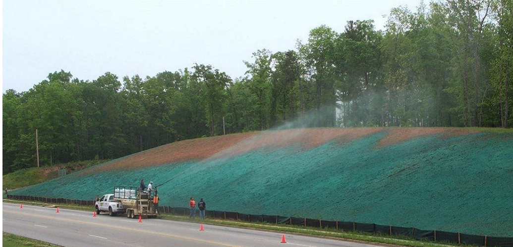
Figura 72. Aplicación de Hidrosiembra en camioneta
