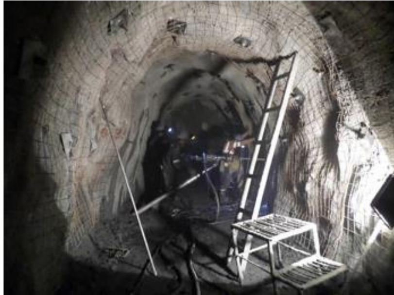
Figura 92. Proceso de construcción de los paraguas de drenaje
