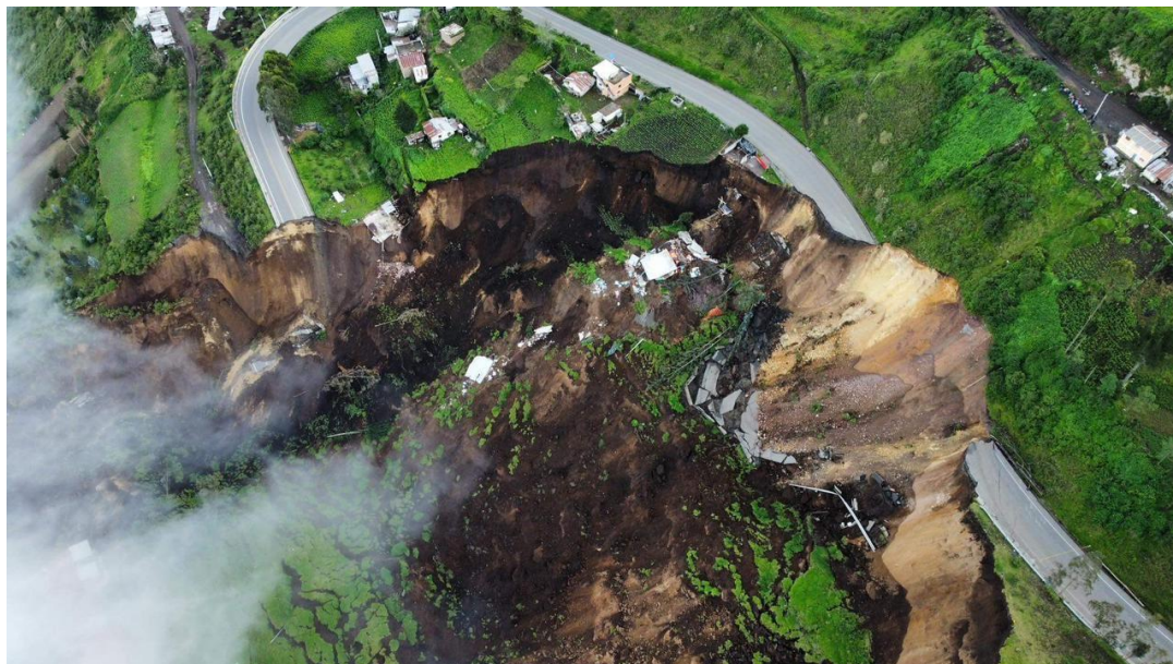
Figura 58. Deslizamiento en Alausí
