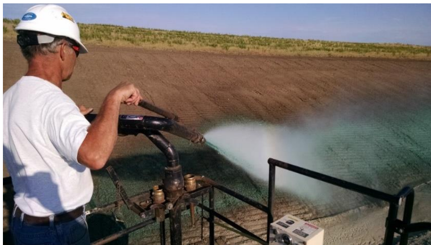
Figura 73. Aplicación de Hidrosiembra
