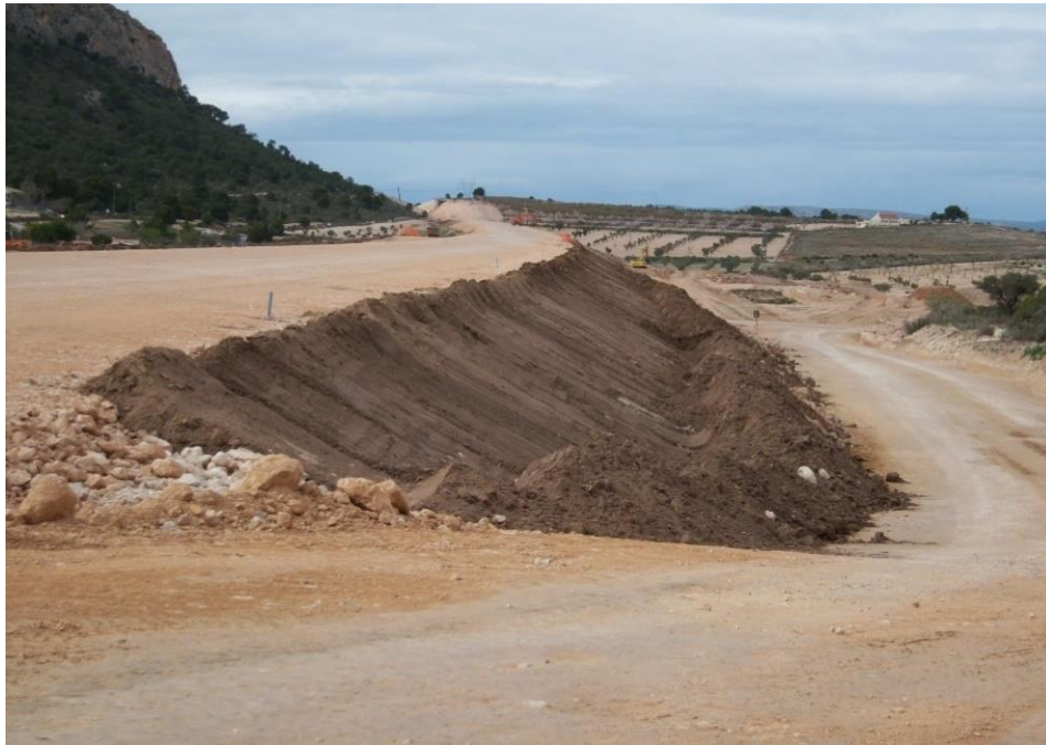
Figura 47. Terraplén construido con material de relleno
