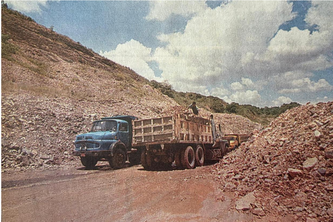
Figura 13. Equipo caminero realizando trabajos de desalojo del material deslizado
