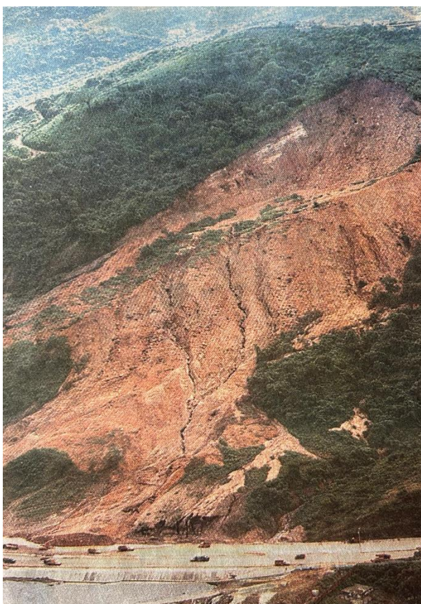
Figura 8. Ramificación del deslizamiento con dirección al centro comercial Riocentro Los Ceibos
