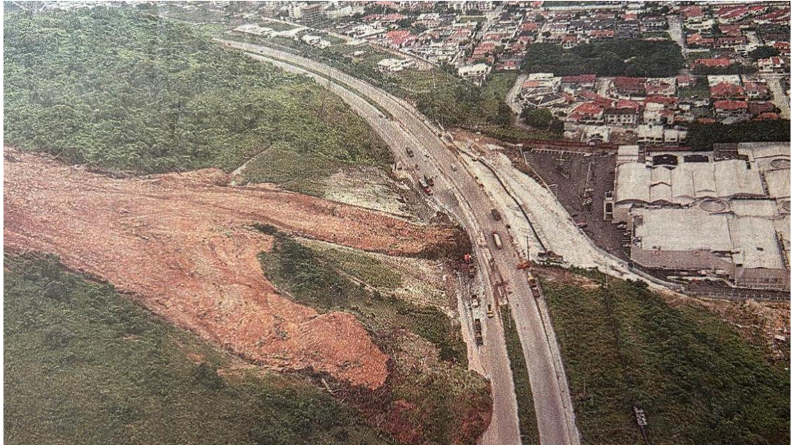
Figura 11. Vía Perimetral colapsada por el deslizamiento de Cerro Azul
