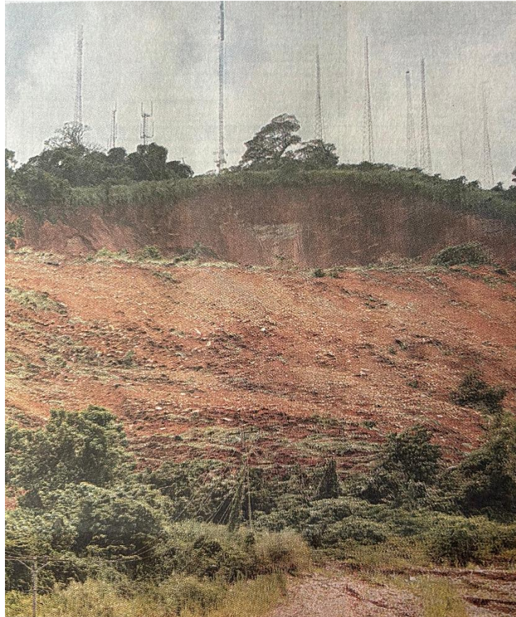
Figura 9. 40 antenas instaladas por empresas privadas con riesgo de caer en caso de continuar los deslaves
