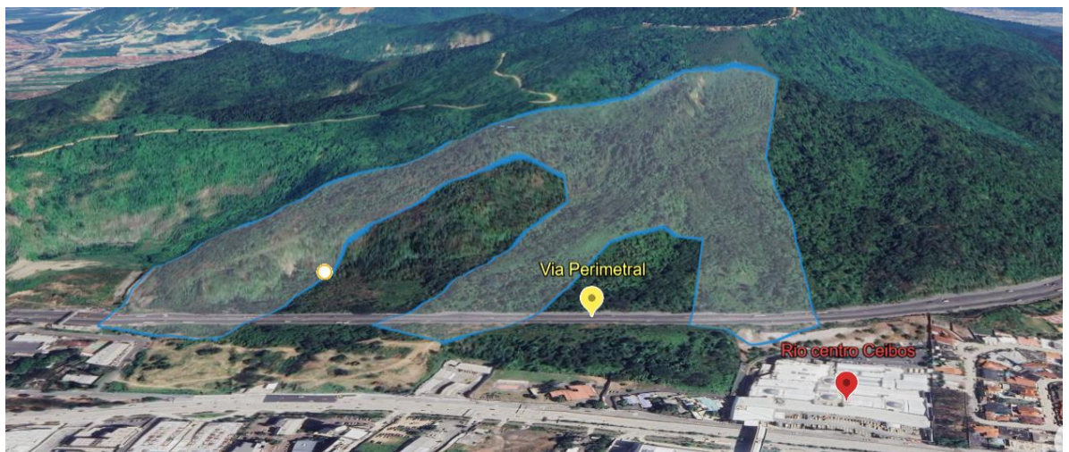
Figura 14. Simulación de deslizamiento de Cerro Azul llegando a interrumpir paso de la Vía Perimetral
