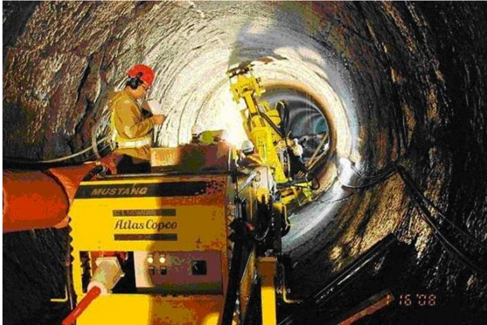
Figura 86. Colocación de los paraguas de drenaje
