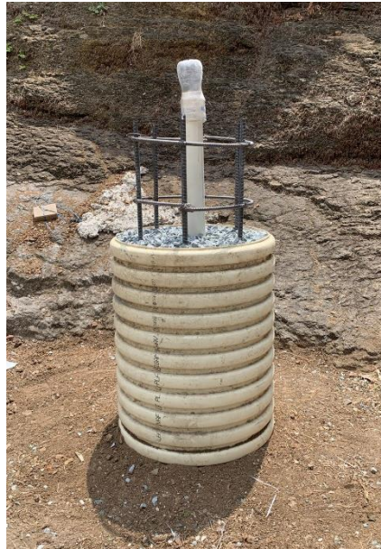
Figura 84 Vaciado de material grueso en el armado del pilote.
