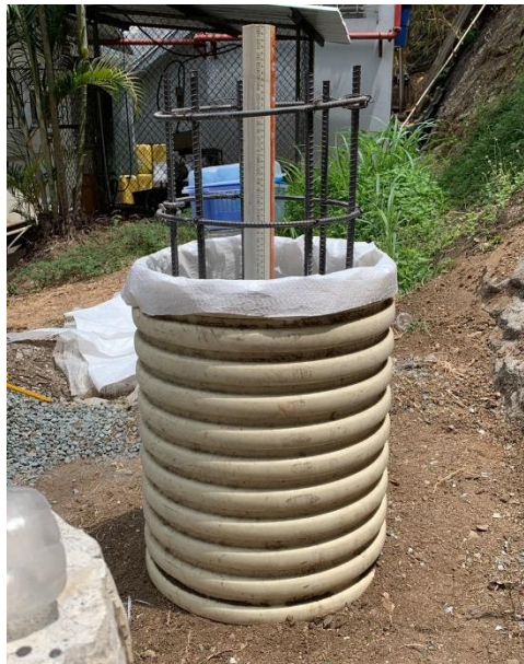
Figura 83 Colocación de geotextil y tubería de inyección-reinyección.
