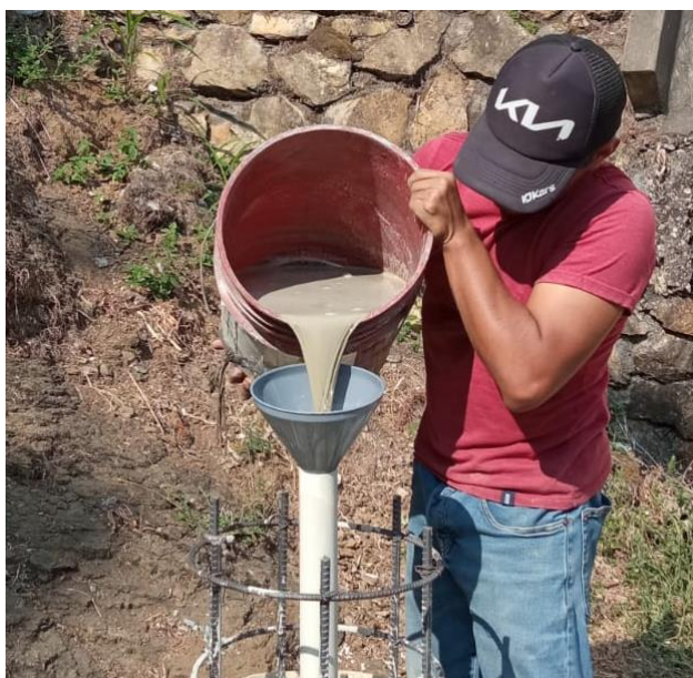
Figura 87 Reinyección de pilote inyectado.
