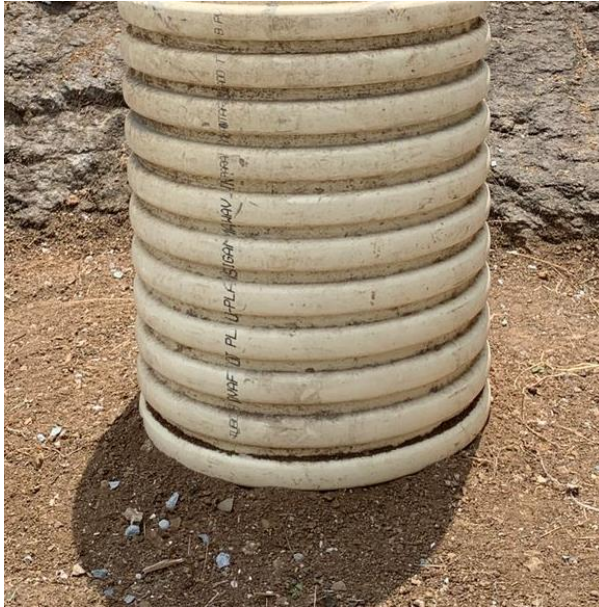
Figura 82 Posicionamiento de camisa de plástico (tubería corrugada de 400 mm).
