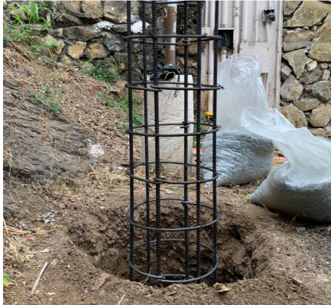
Figura 81 Excavación y colocación de armado estructural.
