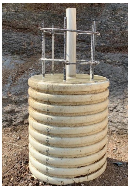
Figura 86 Pilote después de la inyección cementicia.
