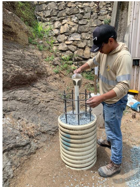
Figura 85 Inyección del pilote con lechada cementicia.
