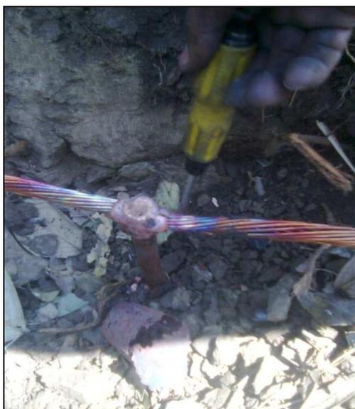
**Figura 3.22 Soldado exotérmico del anillo con electrodo**
