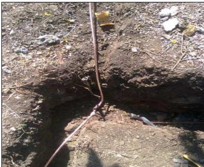
**Figura 3.20 Instalación de red de alambre con electrodos para sistema de tierra**
