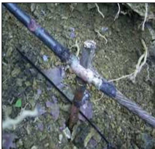
**Figura 3.23 Conector de Puesta a Tierra**
