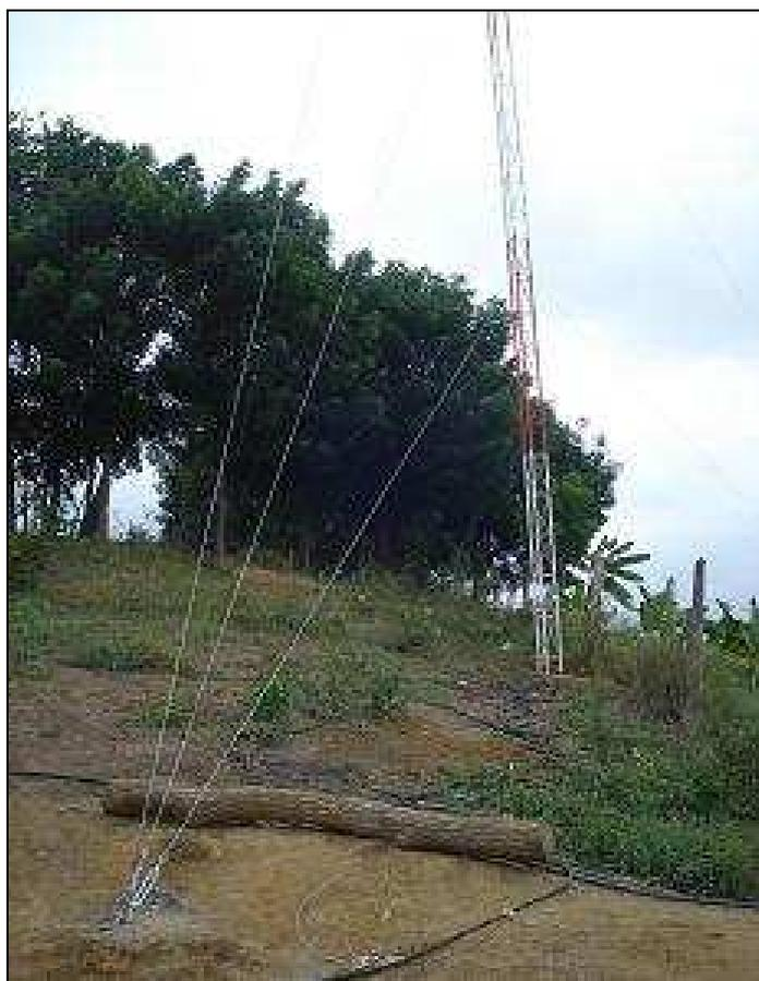
**Figura 3.15 Anclajes que tensionan los vientos de la torre de comunicaciones**
