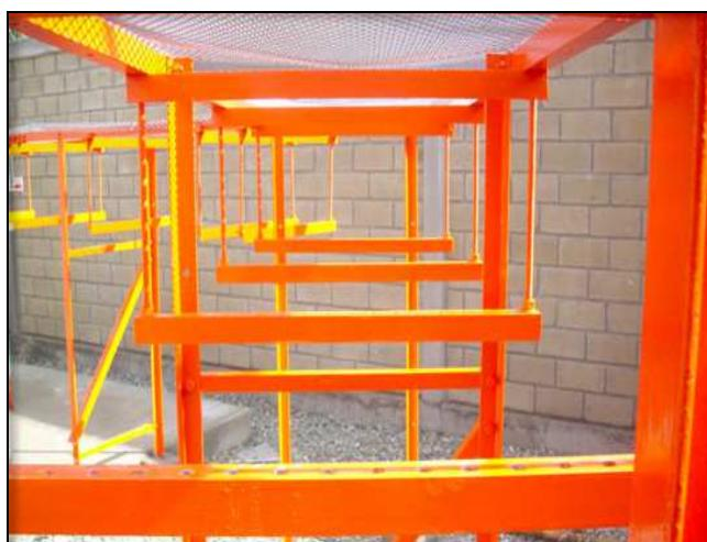
**Figura 2.7 Escalerilla para cables guías de onda de torre auto soportada**
