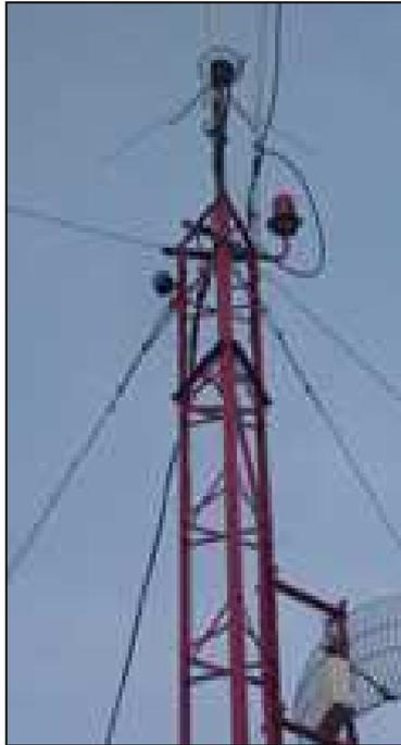
**Figura 3.25 Conexión de pararrayo, luz de baliza y antenas**
