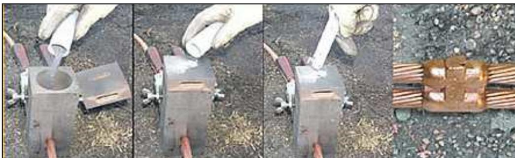
**Figura 3.21 Proceso de soldadura exotérmica**
