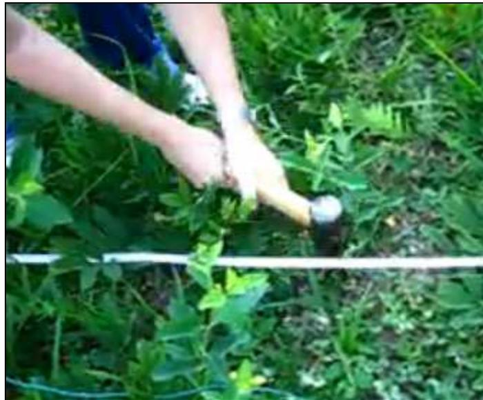
**Figura 3.11 La plantación de electrodos en sitio escogido para la torre**
