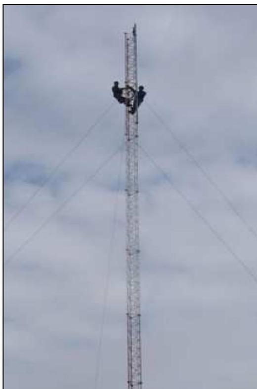
**Figura 3.14 Montaje de la torre de comunicaciones en Limoncito**
