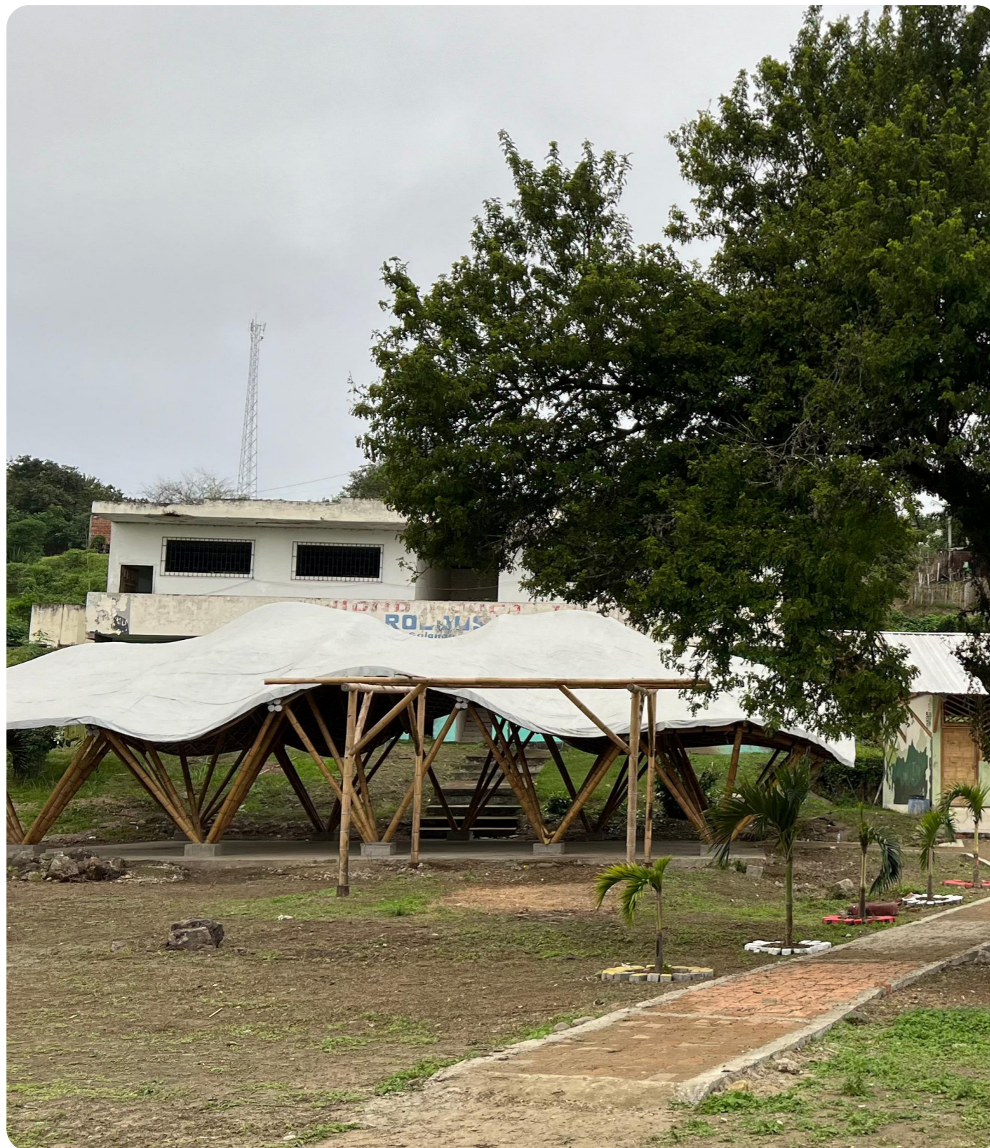
Imagen 2. Infraestructura existente Autor: Christopher Chuquicusma Año: 2024
