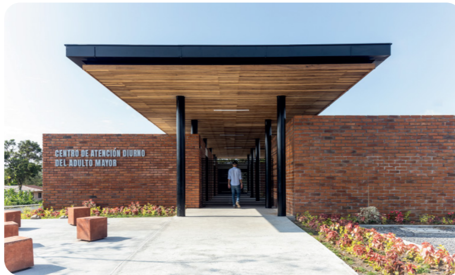
Imagen 9 . Centro de Atención Diurno Autor: Archdaily. (09 de Enero de 2023). Obtenido de https://www.archdaily.cl/cl/994521/centro-de-atencion-diurno-del-adultoayor-side-fx-arquitectura?ad_source=search&ad_medium=projects_tab
